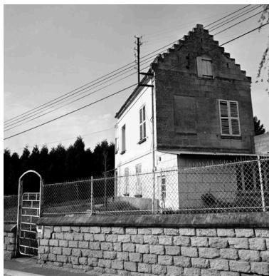
Logement d'ouvriers. Phot. Patrick Glotain IVR22_19936000397X
