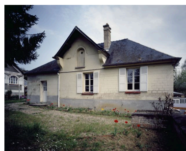
Logement patronal : flanc sud. Phot. Patrick Glotain IVR22_19936000814VA
