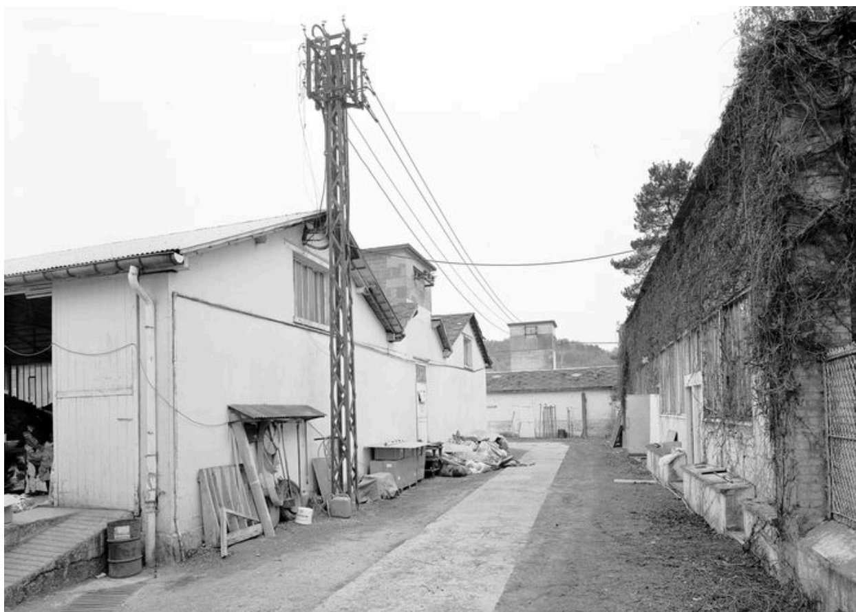
Atelier de fabrication de robinetterie : flanc ouest.
