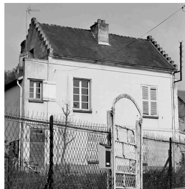
Logement d'ouvriers. Phot. Patrick Glotain IVR22_19936000395X
