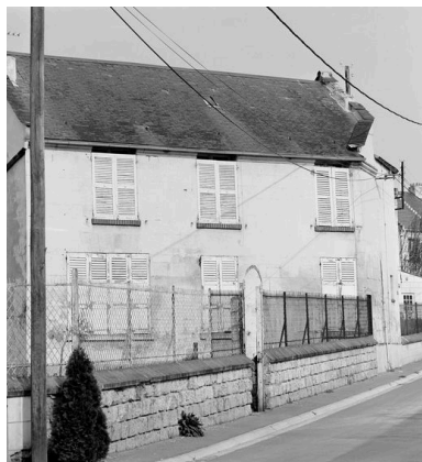
Logement d'ouvriers. Phot. Patrick Glotain IVR22_19936000396X
