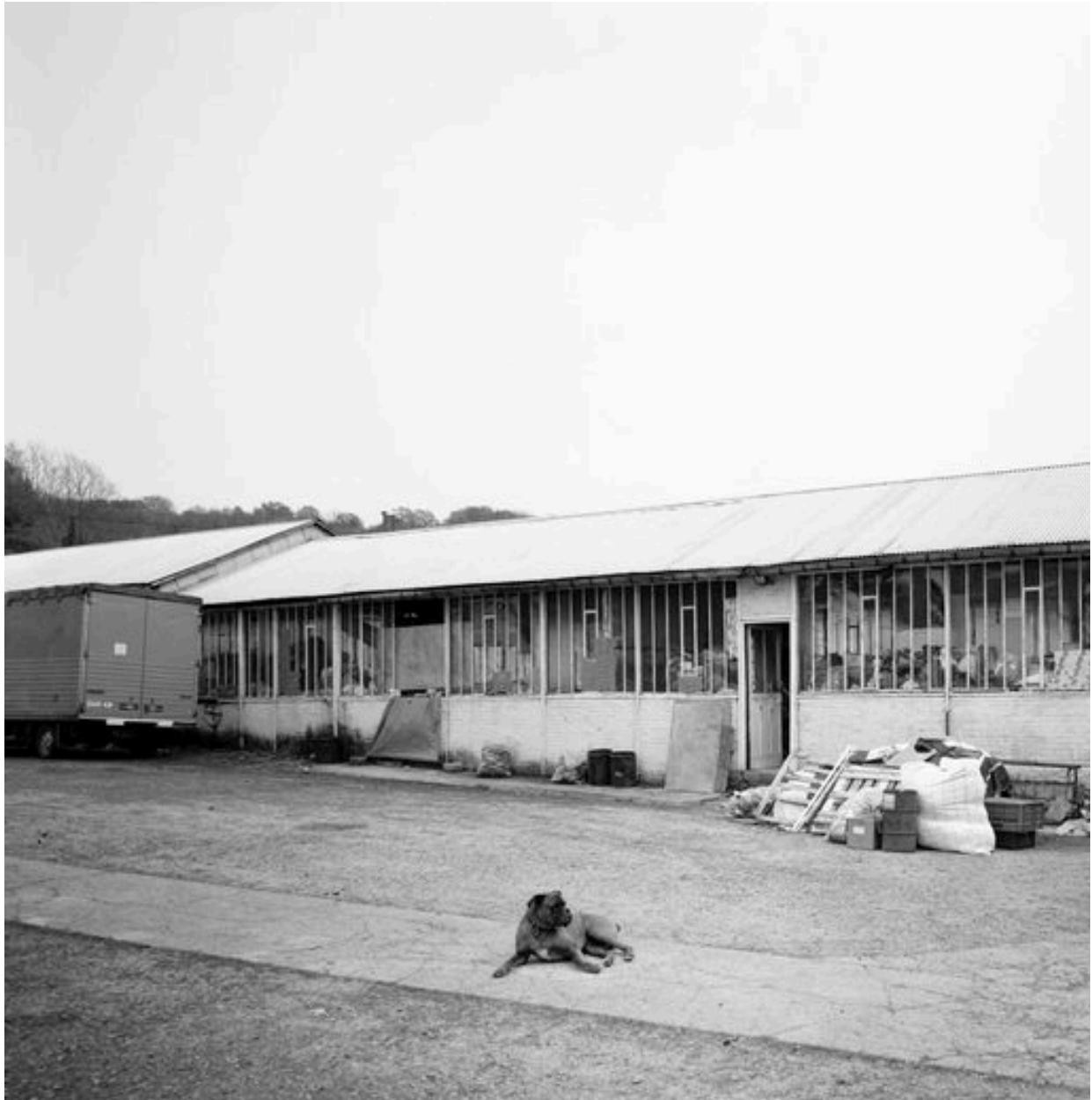
Atelier de fabrication de la robinetterie : flanc nord.
