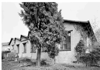
Atelier de fabrication de l'usine de verres optiques : flanc ouest. Phot. Patrick Glotain IVR22_19936000407V
