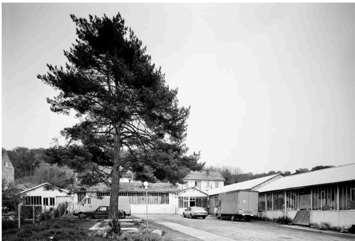
Ateliers de fabrication de la robinetterie : flanc nord-est.
