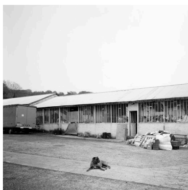
Atelier de fabrication de la robinetterie : flanc nord. Phot. Patrick Glotain IVR22_19936000412V
