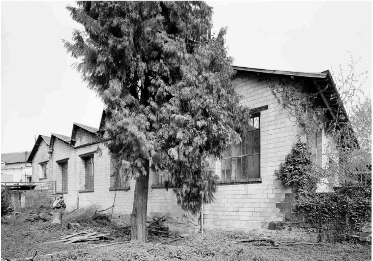
Atelier de fabrication de l'usine de verres optiques : flanc ouest.
