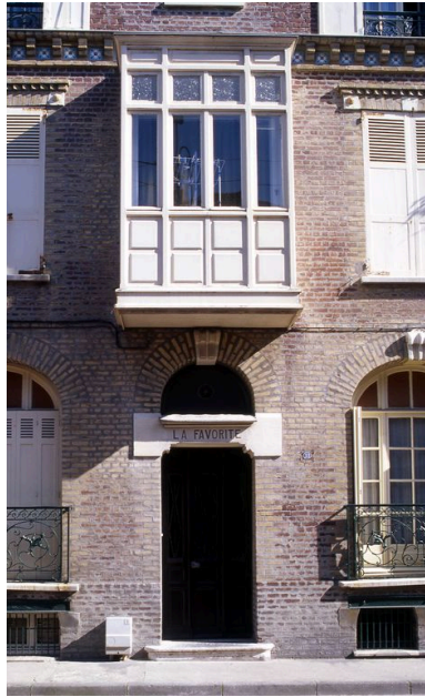
Détail de la travée d'entrée de la maison dite La Favorite, avec bow-window en surplomb. Phot. Marie-Laure Monnehay-Vulliet IVR22_20048000354XA
