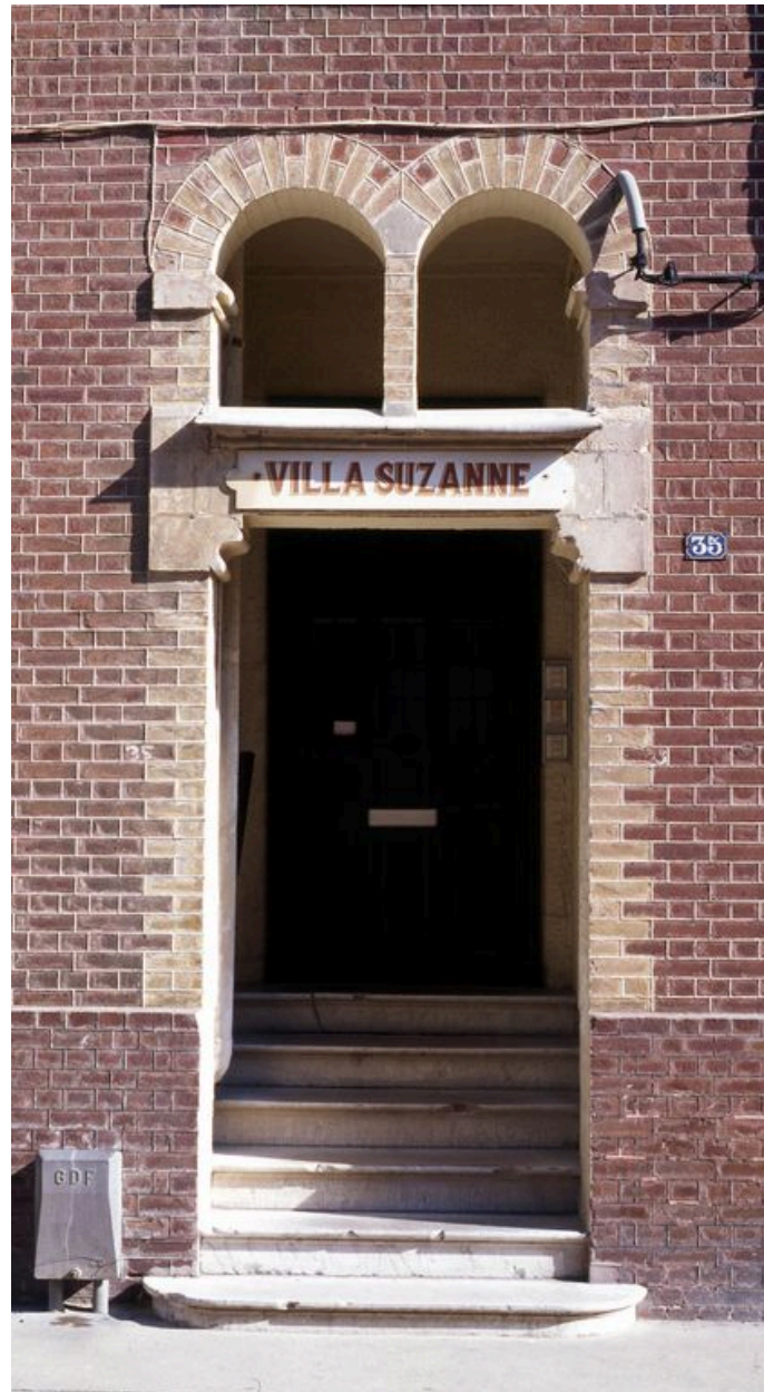
Détail de du porche dans-oeuvre de la Villa Suzanne.
