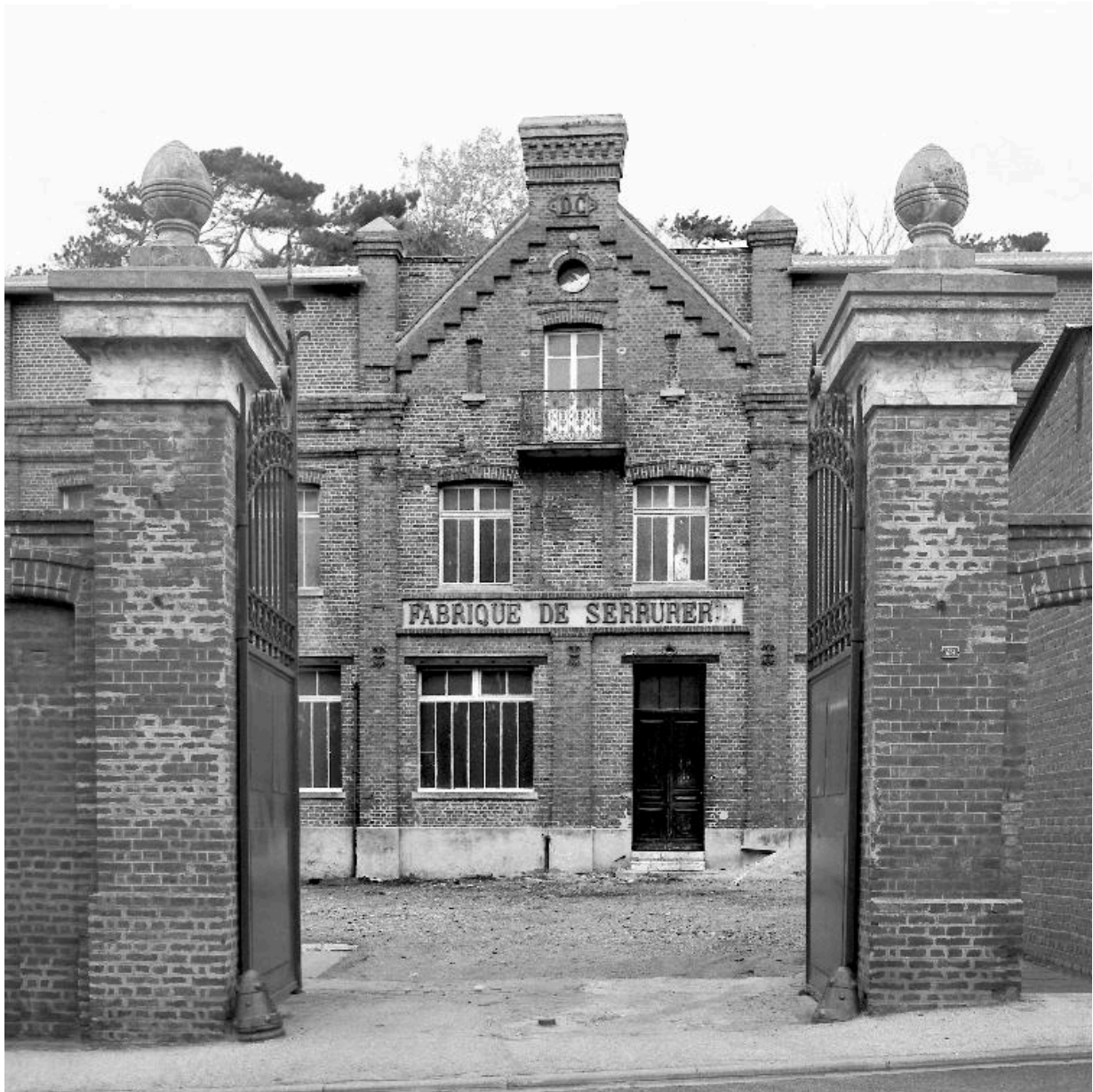
Vue de la travée principale de la fabrique de serrurerie, en 1990.
