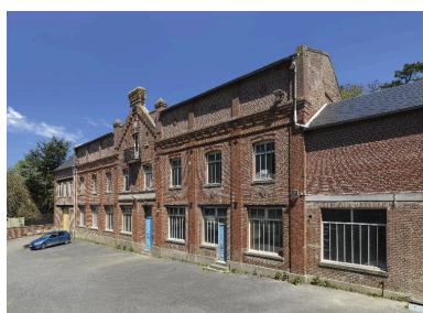
Vue de trois-quarts de la façade antérieure de l'atelier principal. Phot. Thierry Lefébure IVR22_20158000346NUC2AQ
