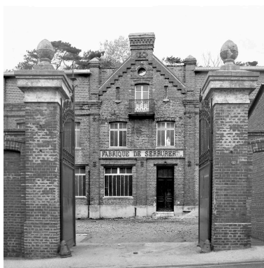
Vue de la travée principale de la fabrique de serrurerie, en 1990. Phot. Phot'R IVR22_19908000490X
