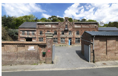
Vue générale depuis la rue du Général-Leclerc. Phot. Thierry Lefébure IVR22_20158000349NUC2AQ
