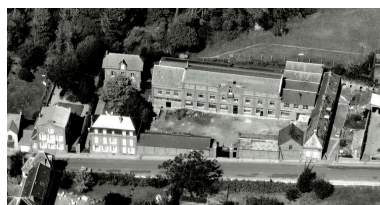
Vue de l'ancienne usine, en 1988.
