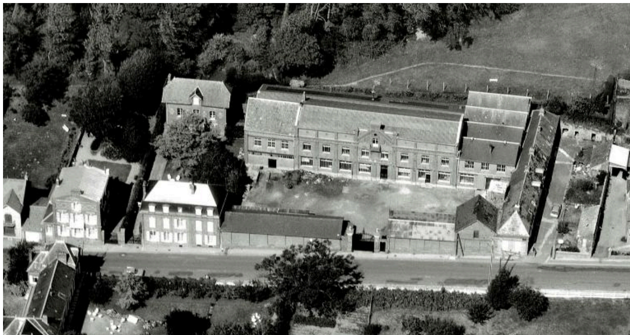
Vue de l'ancienne usine, en 1988.
