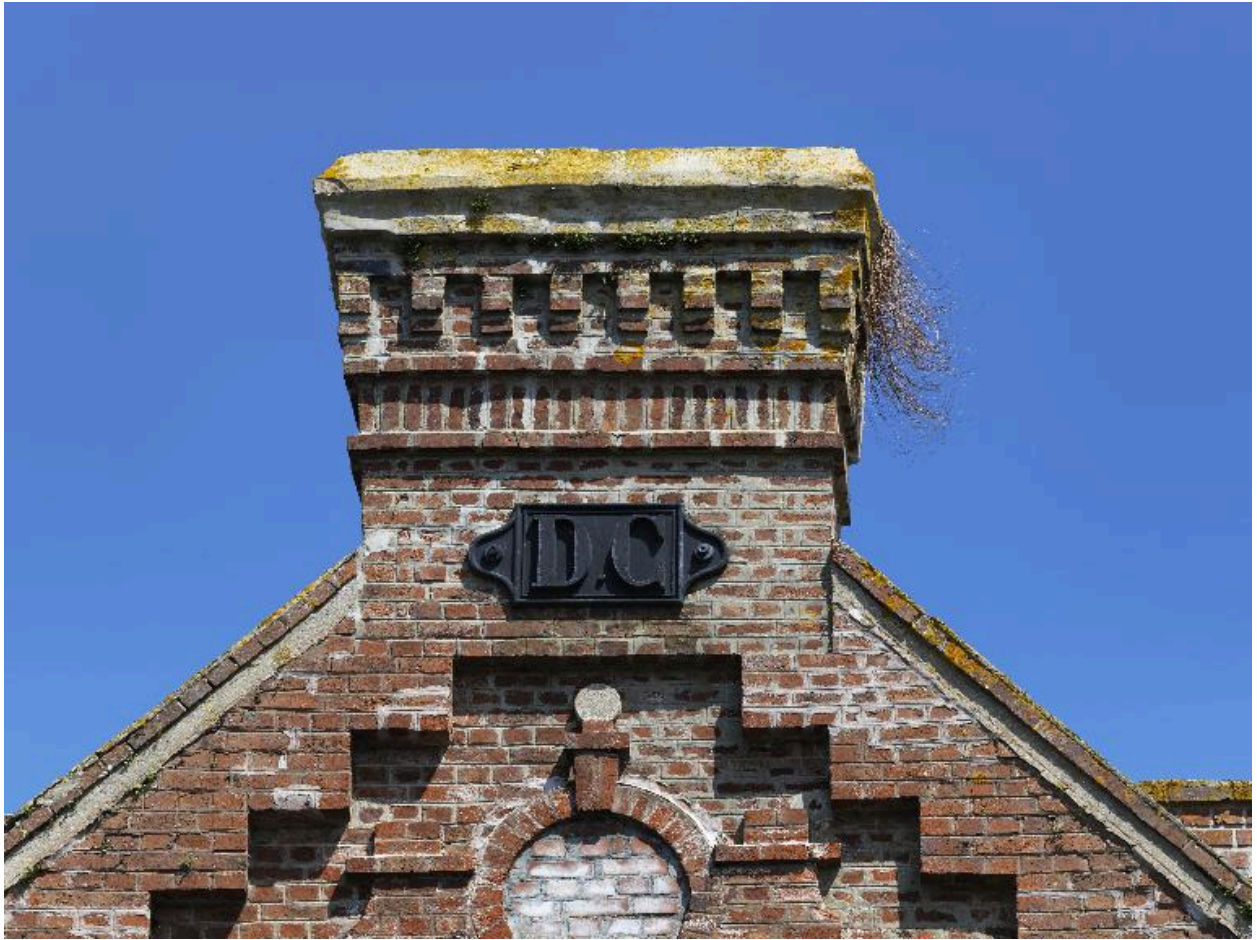
Détail des initiales en fer d'ancrage de la souche de cheminée.
