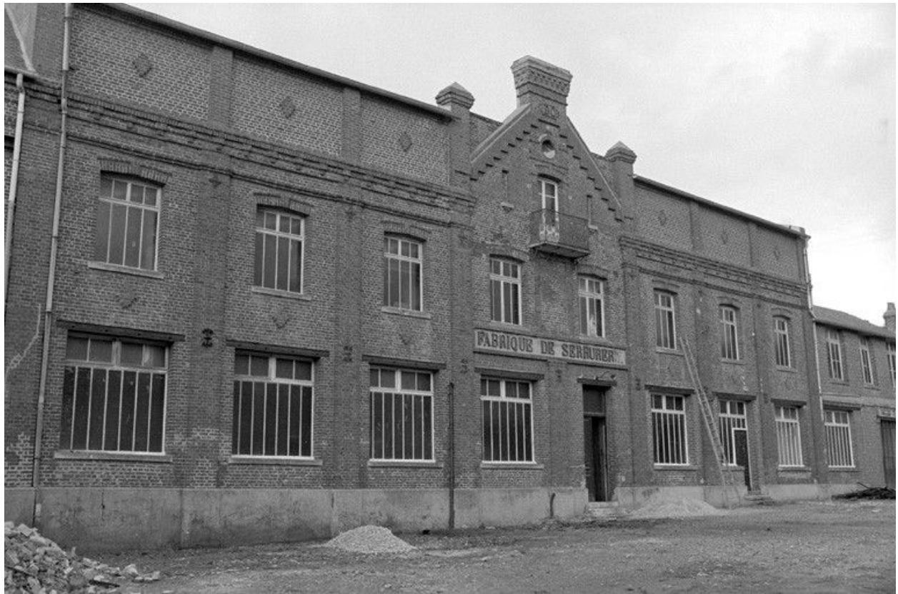
Atelier de fabrication, élévation antérieure, en 1990.
