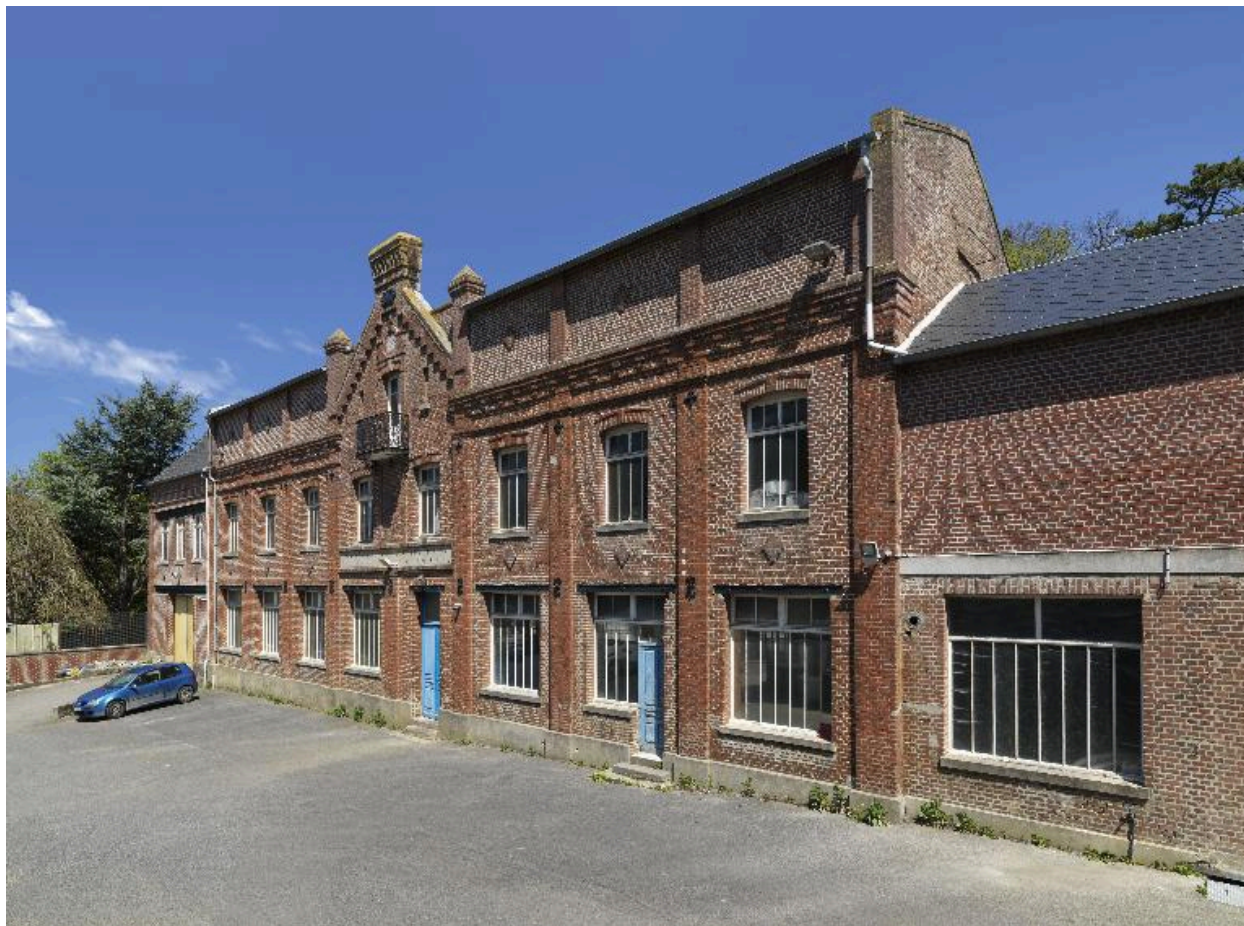
Vue de trois-quarts de la façade antérieure de l'atelier principal.
