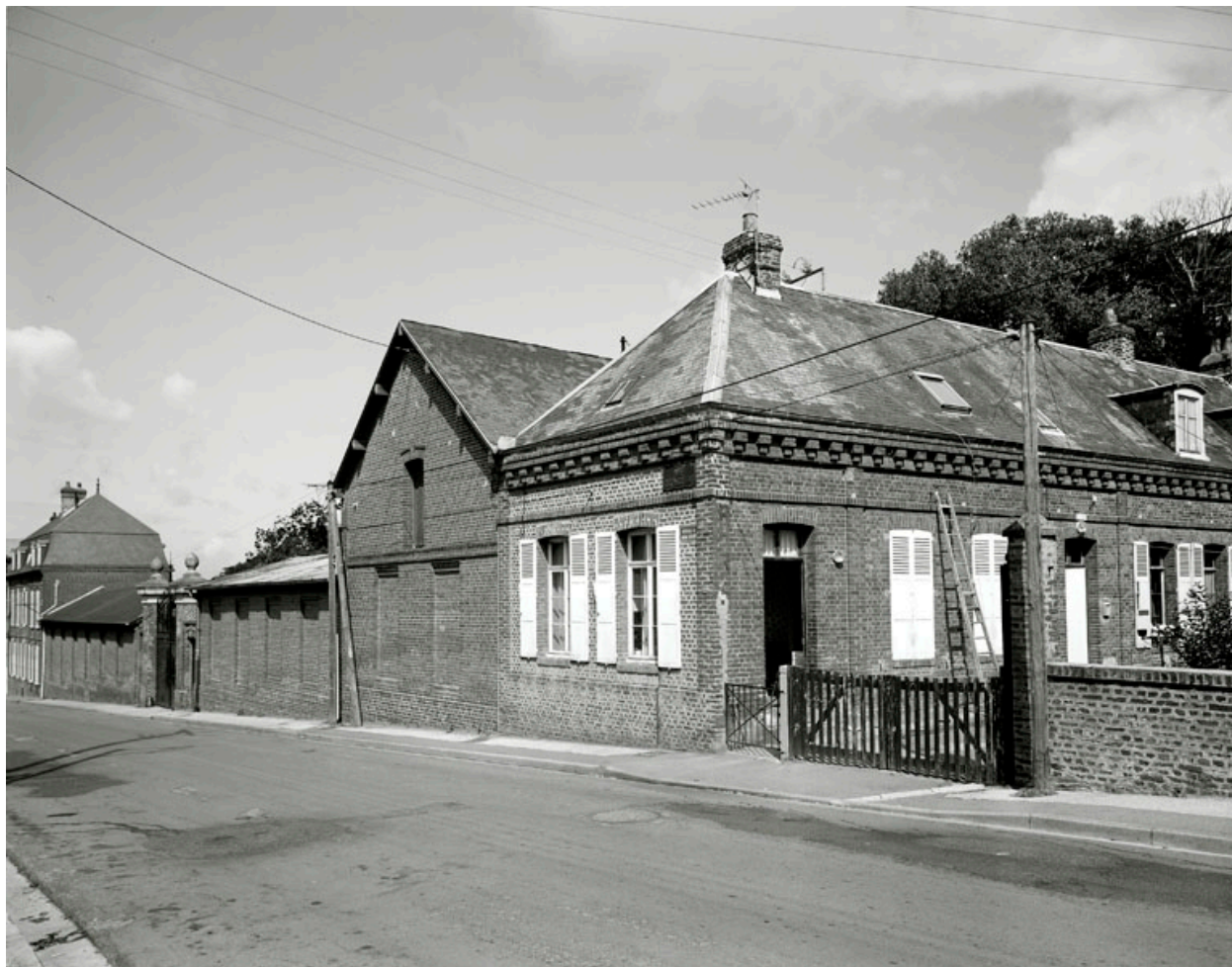
Vue des bâtiments sur rue en 1988. Les logements ouvriers au premier plan.
