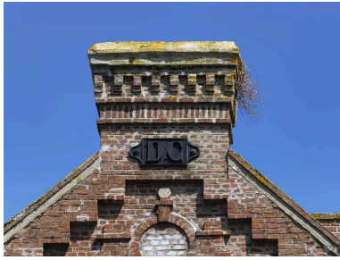
Détail des initiales en fer d'ancrage de la souche de cheminée.
