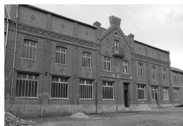
Atelier de fabrication, élévation antérieure, en 1990. Phot. Francis Dubuc IVR22_19908000724Z
