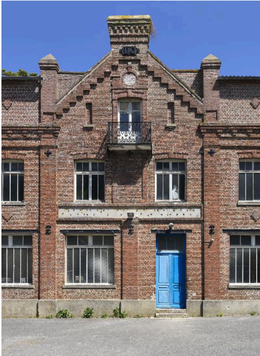
Détail des travées centrales de l'atelier principal.
