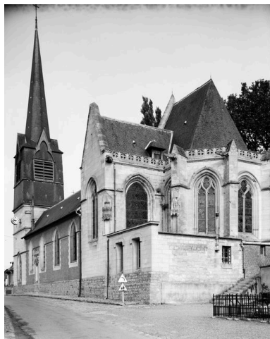
Vue générale. Phot. Jean-Michel Perrin IVR22_19846000977V
