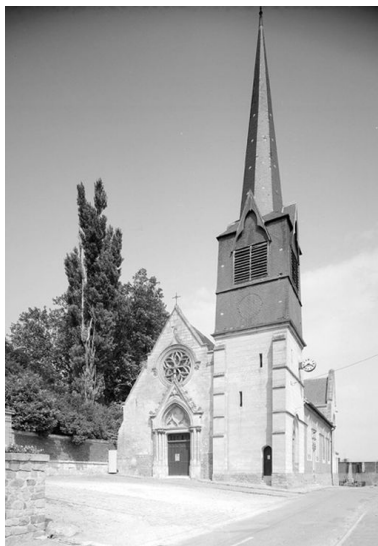
Façade occidentale. Phot. Jean-Michel Perrin IVR22_19846000978V
