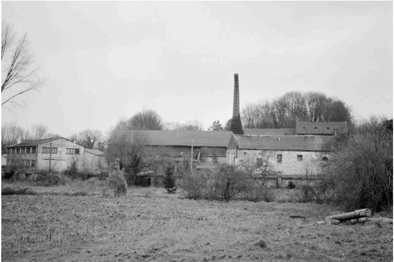
Vue de situation : bâtiments de la féculerie et de l'usine d'articles en matière plastique (à gauche).
