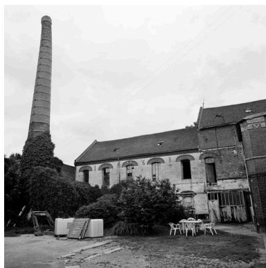
Atelier de fabrication principal, cheminée d'usine. Phot. Patrick Glotain IVR22_19936000621X
