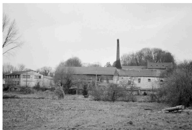
Vue de situation : bâtiments de la féculerie et de l'usine d'articles en matière plastique (à gauche). Phot. Bertrand Fournier IVR22_20006000067Z
