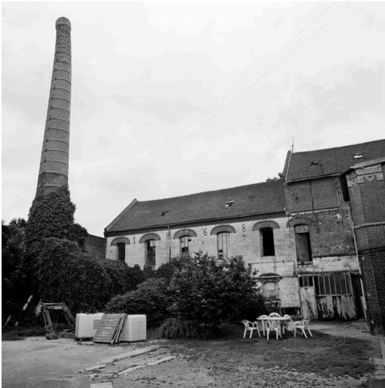
Atelier de fabrication principal, cheminée d'usine.
