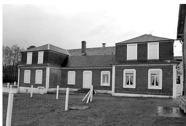
Elévation nord du logis. Phot. Xavier-Philippe Guiochon IVR22_19970202393Z
