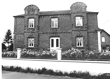
Elévation orientale du logis. Phot. Xavier-Philippe Guiochon IVR22_19980203075Z
