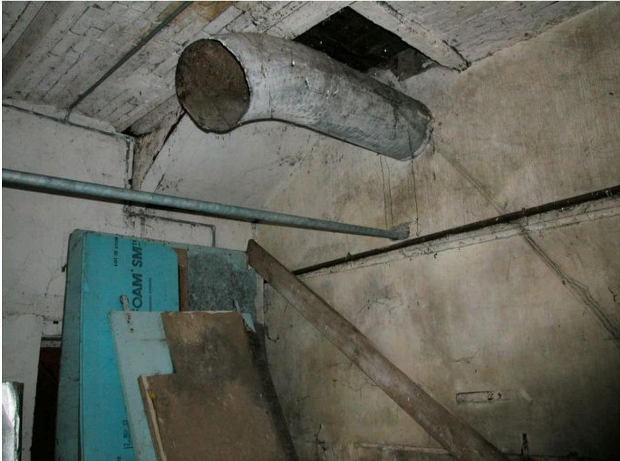
Détail de l'arrivée de la conduite forcée qui alimentait la roue hydraulique par dessus.
