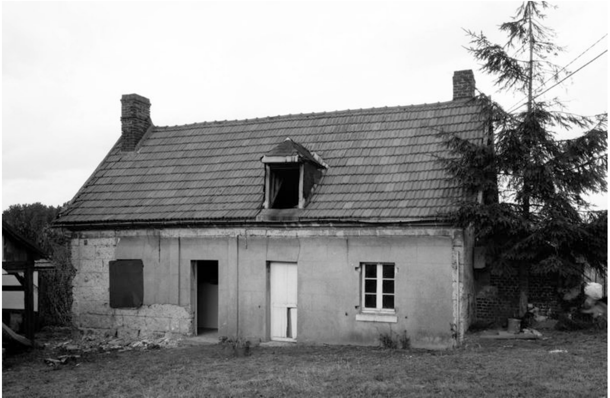
Logis. Elévation antérieure.
