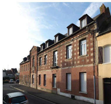
Vue générale depuis le nord. Phot. Marie-Laure Monnehay-Vulliet IVR22_20158001056NUC2A
