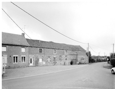
Vue d'un alignement situé chemin de Ropsies au hameau de Ropsies. Phot. Pierre Thibaut IVR31_20055900594V
