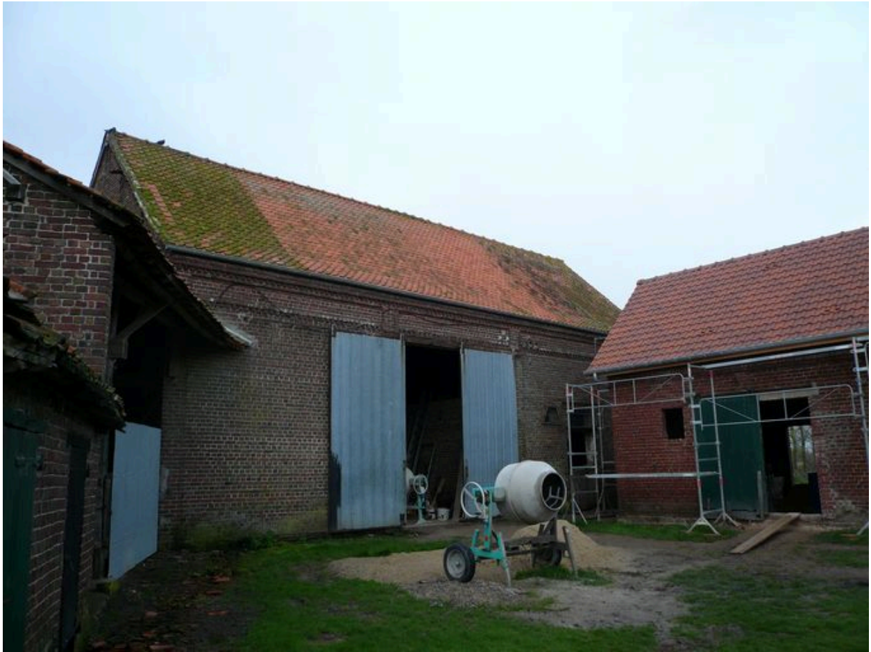
Vue de la grange.
