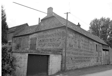
Vue générale depuis le nord-est. Phot. Xavier-Philippe Guiochon IVR22_19980202341Z
