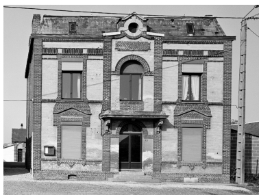
Façade de l'ancienne mairie-école construite vers 1910. Phot. Thierry Lefébure IVR22_19930200451X
