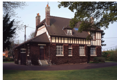
Elévation postérieure. Phot. Pierre Thibaut IVR31_20085900368XA
