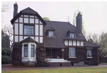
Elévation antérieure de la maison de style régionaliste. Phot. Pierre Thibaut IVR31_20085900367XA
