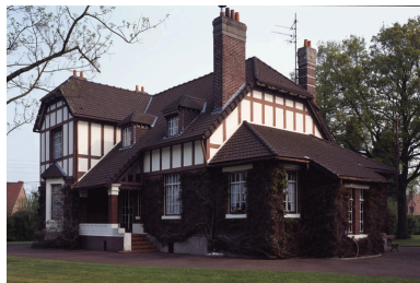
Vue générale de trois quarts. Phot. Pierre Thibaut IVR31_20085900369XA
