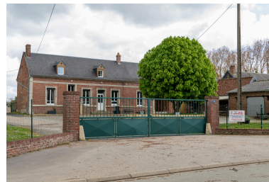
Logis d'une ancienne ferme, n°22 de la rue des Charrons, vue prise depuis l'ouest.
