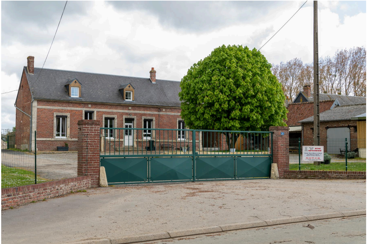
Logis d'une ancienne ferme, n°22 de la rue des Charrons, vue prise depuis l'ouest.
