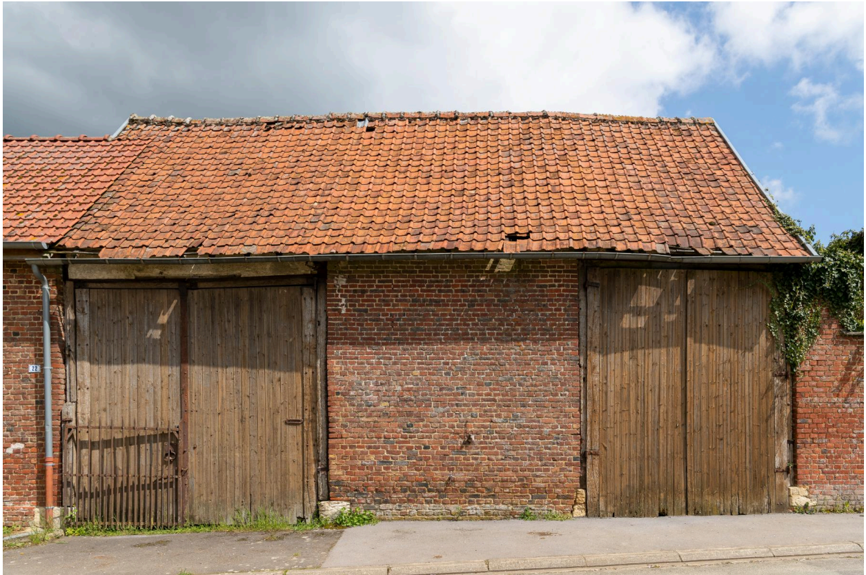
Ancienne grange sur rue avec entrée charretière, n°22 de la rue des Charrons, vue prise depuis l'ouest.
