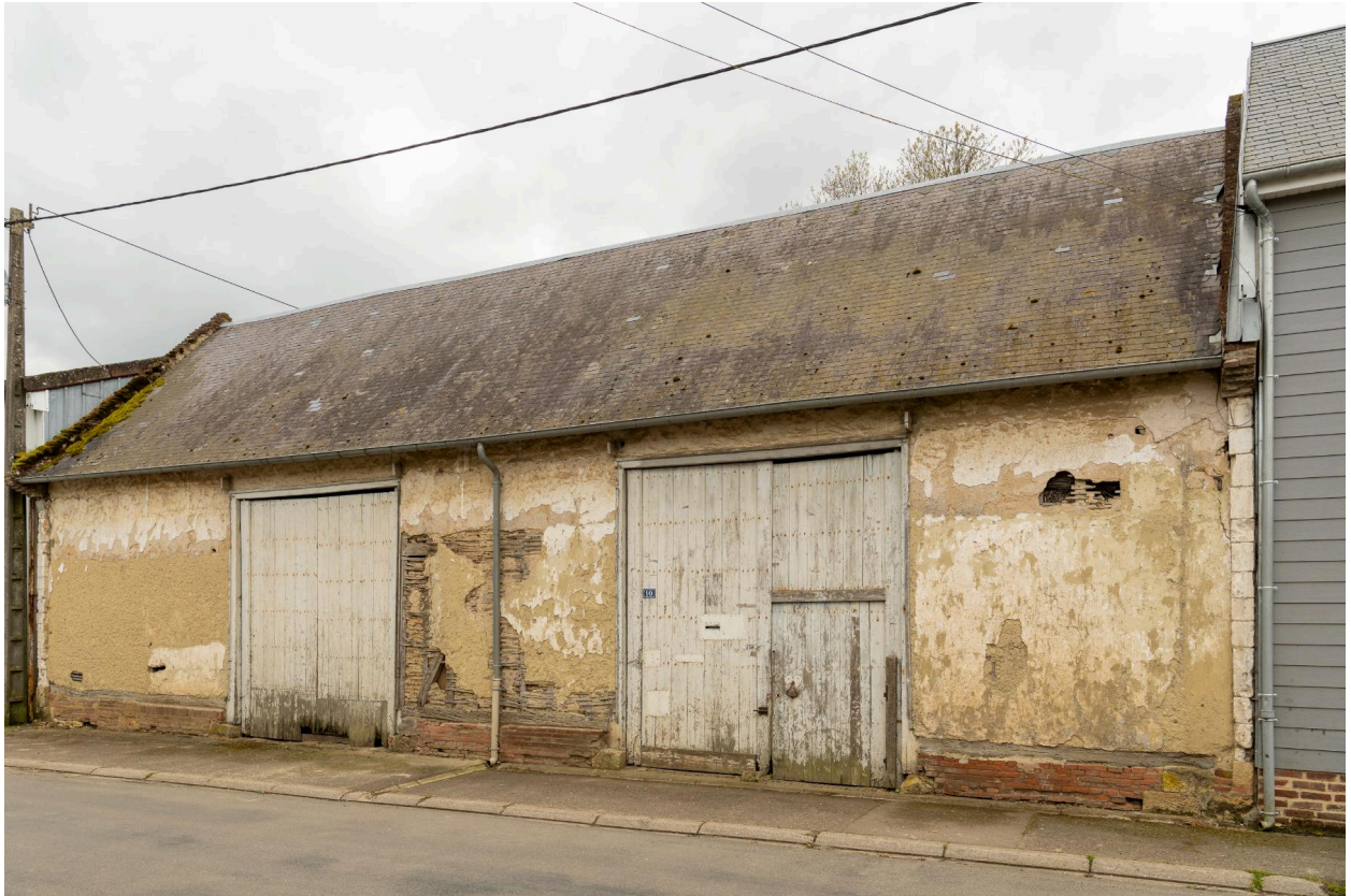
Ancienne grange en torchis et pan de bois, n°10 de la rue du Pressoir, vue prise depuis l'est.
