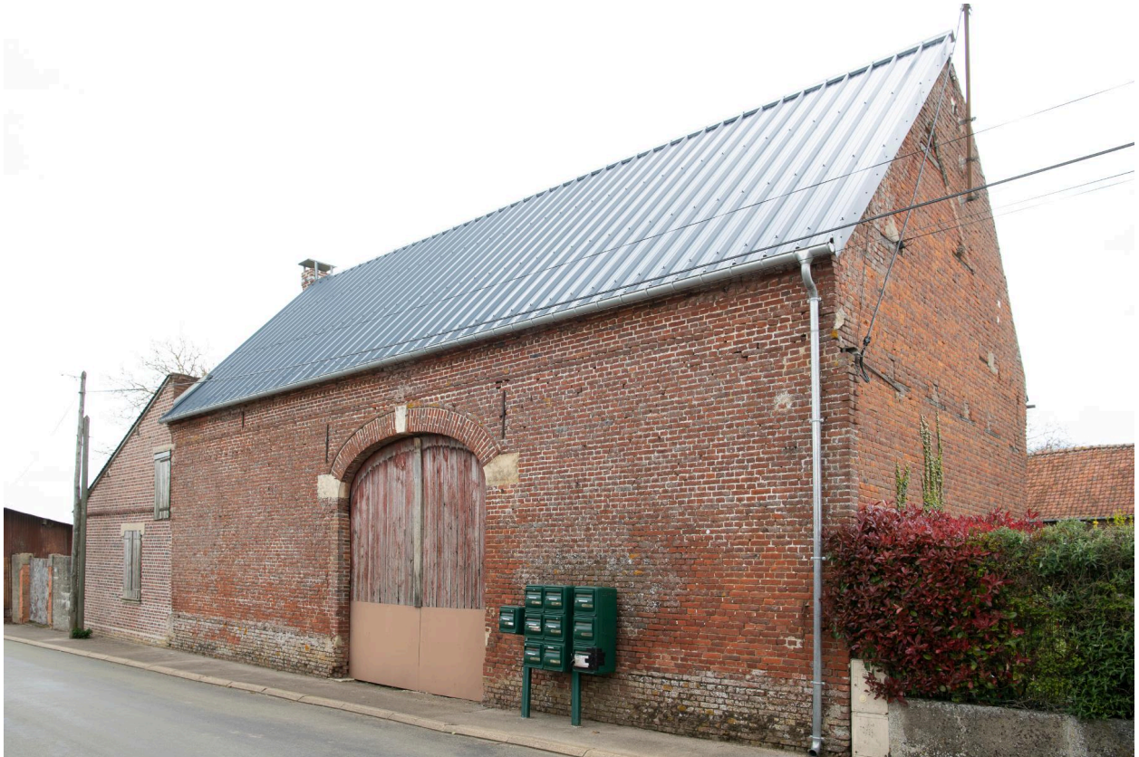
Grange reconstruite en brique, n°8 de la rue du Grand Cour, vue prise depuis le sud.
