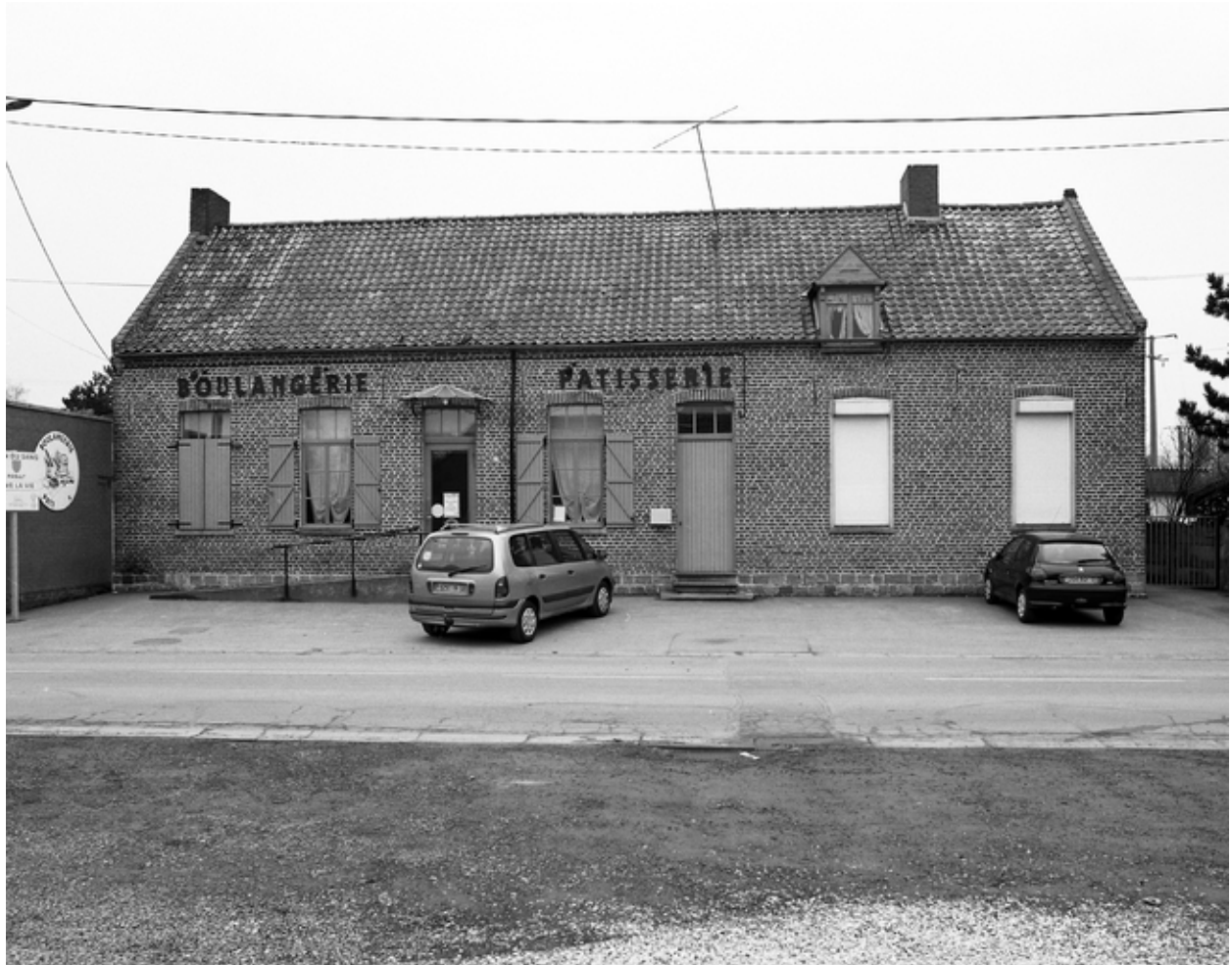
Vue générale, élévation antérieure.
