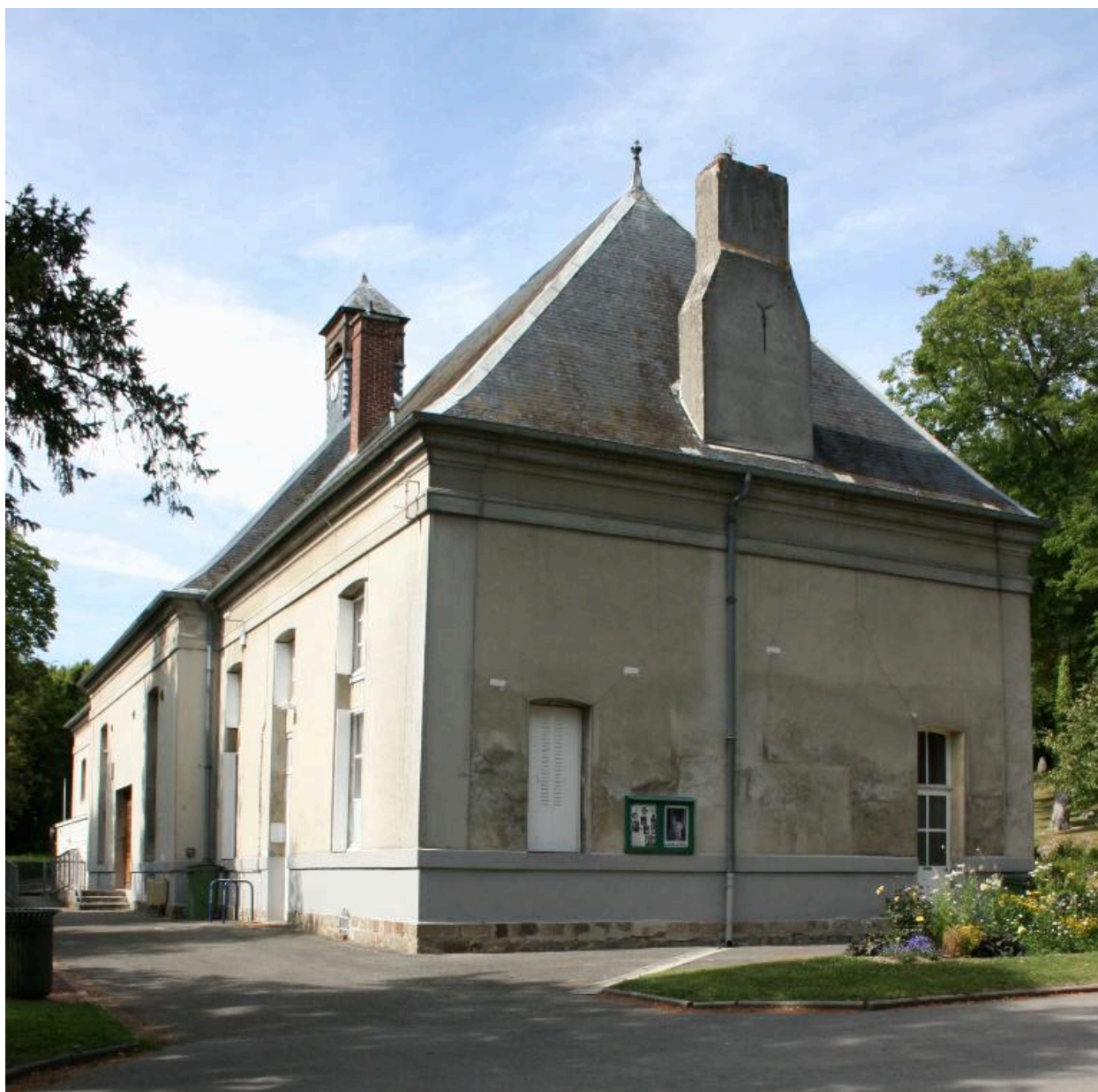
Vue depuis le sud-est.
