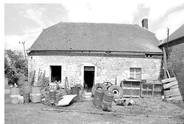
Façade antérieure du logis. Phot. Pierre-Yves Brest IVR22_19980202532Z
