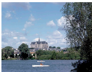
Vue générale de la collégiale et de son environnement, depuis le sud.
