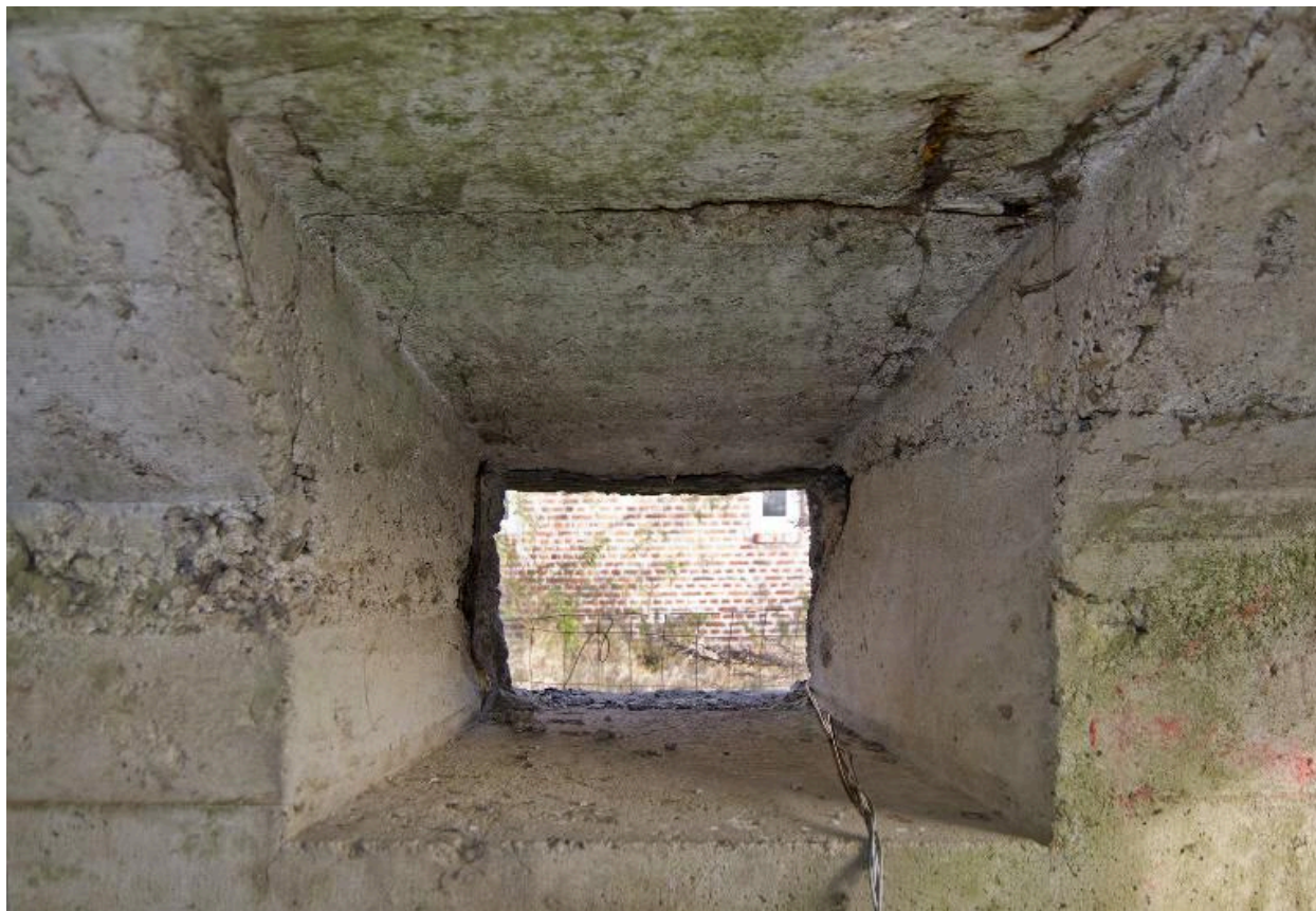
Guérite casematée (Bat. A). Vue intérieure de l'ouverture située dans l'élévation est
