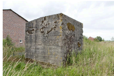
Guerite casematée (Bat. A). Vue de trois-quarts arrière, vers sud-est Phot. Jean-Marc Ramette IVR31_20145904726NUCA
