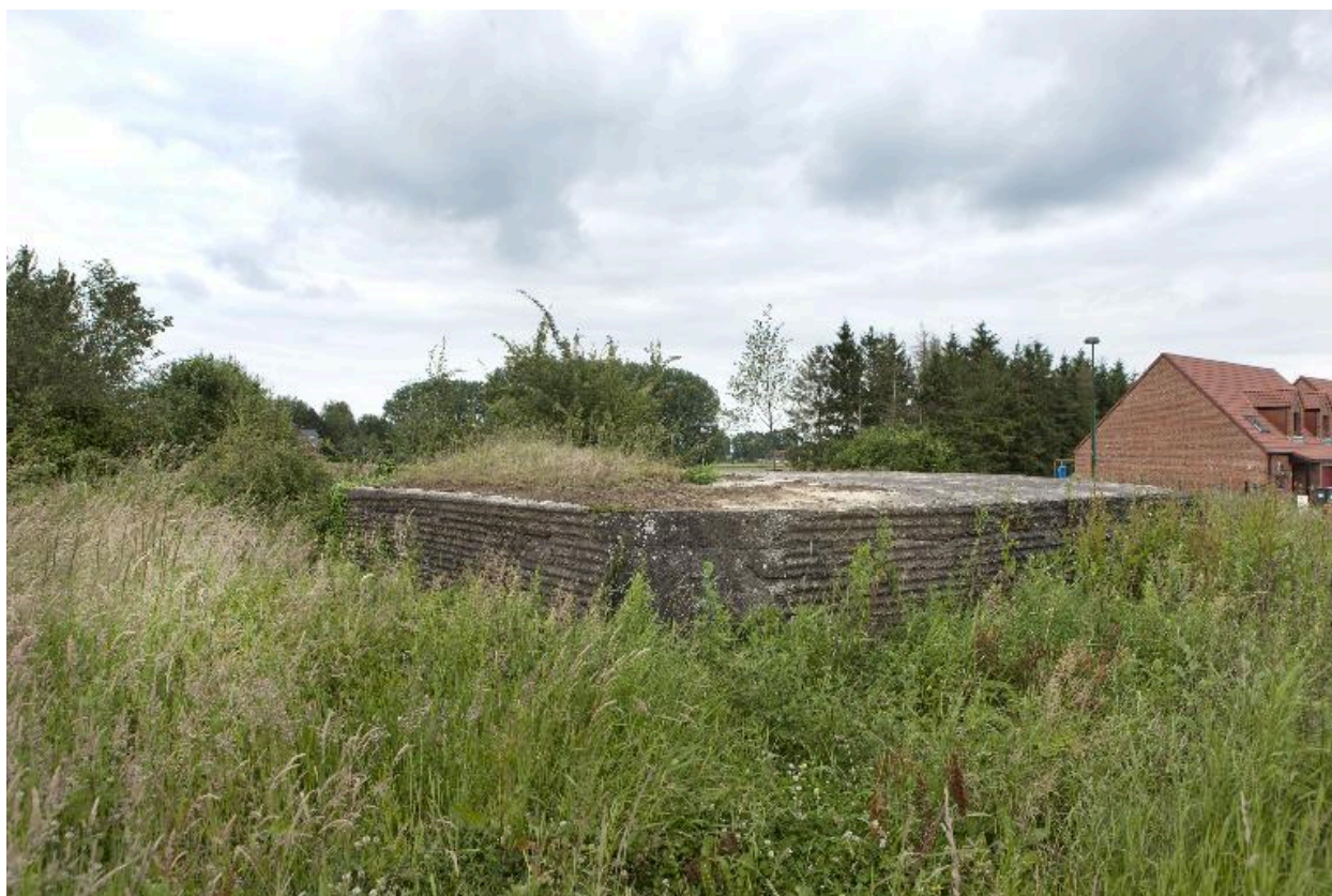
Casemate à personnel (Bat. B)
