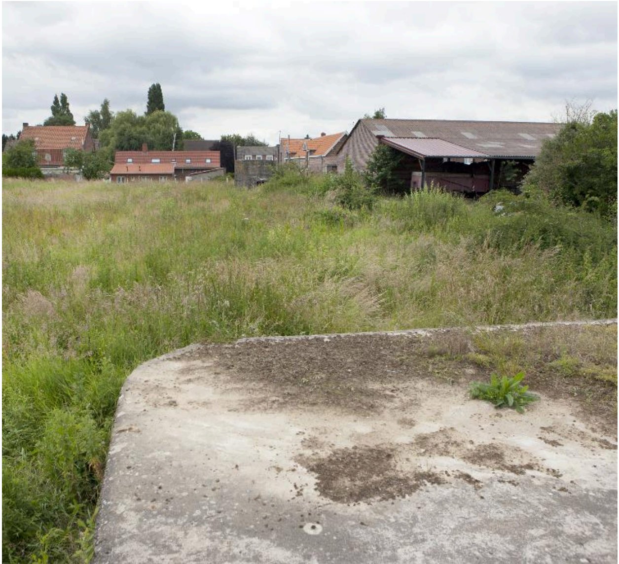
Guérite casematée (Bat. A), dans le fond, depuis le couvrement de la casemate à personnel (Bat. B)
