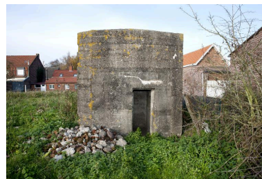
Guerite casematée (Bat. A). Entrée sur l'élévation sud Phot. Jean-Marc Ramette IVR32_20165901416NUCA
