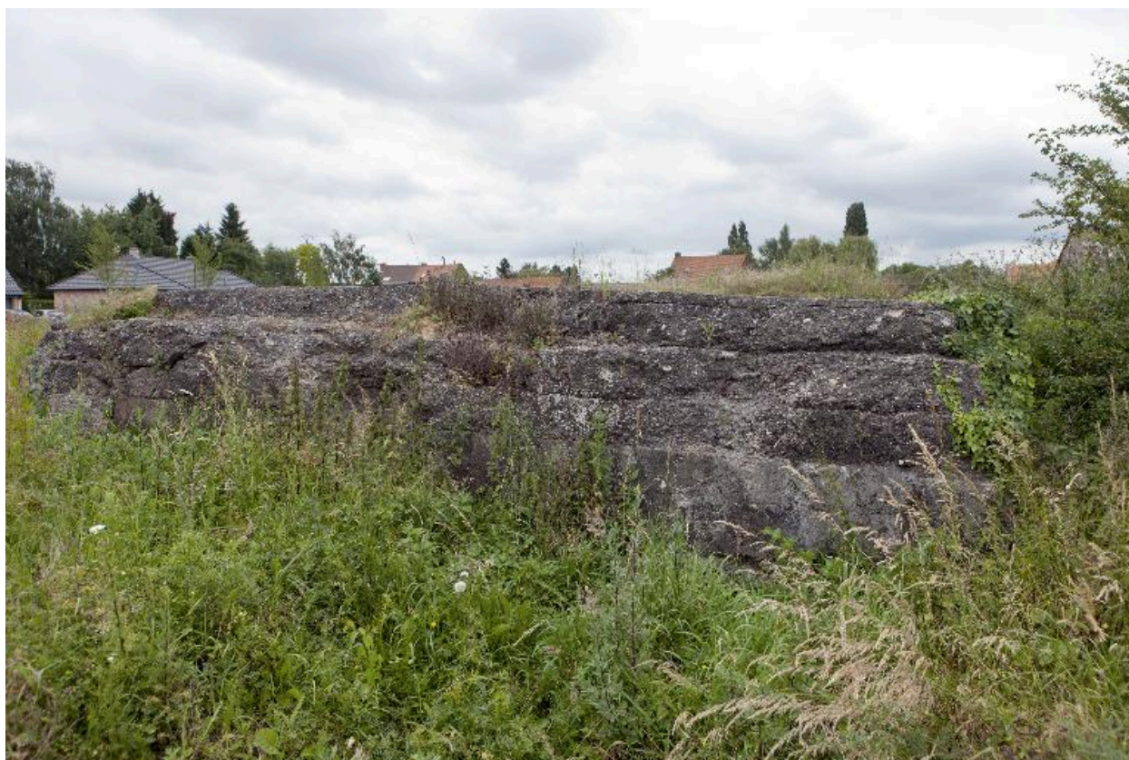
Casemate à personnel (Bat. B)
