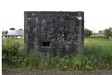
Guerite casematée (Bat. A) vers l'ouest Phot. Jean-Marc Ramette IVR31_20145904722NUCA
