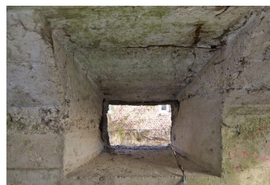
Guerite casematée (Bat. A). Vue intérieure de l'ouverture située dans l'élévation est Phot. Jean-Marc Ramette IVR32_20165901414NUCA
