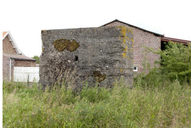
Guerite casematée (Bat. A). Elévation ouest Phot. Jean-Marc Ramette IVR31_20145904724NUCA
