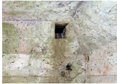
Guérite casematée (Bat. A). Depuis l'intérieur : Ouverture d'aération dans le mur ouest Phot. Jean-Marc Ramette IVR32_20165901413NUCA
