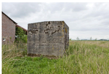
Guerite casematée (Bat. A). Elévation nord Phot. Jean-Marc Ramette IVR31_20145904727NUCA
