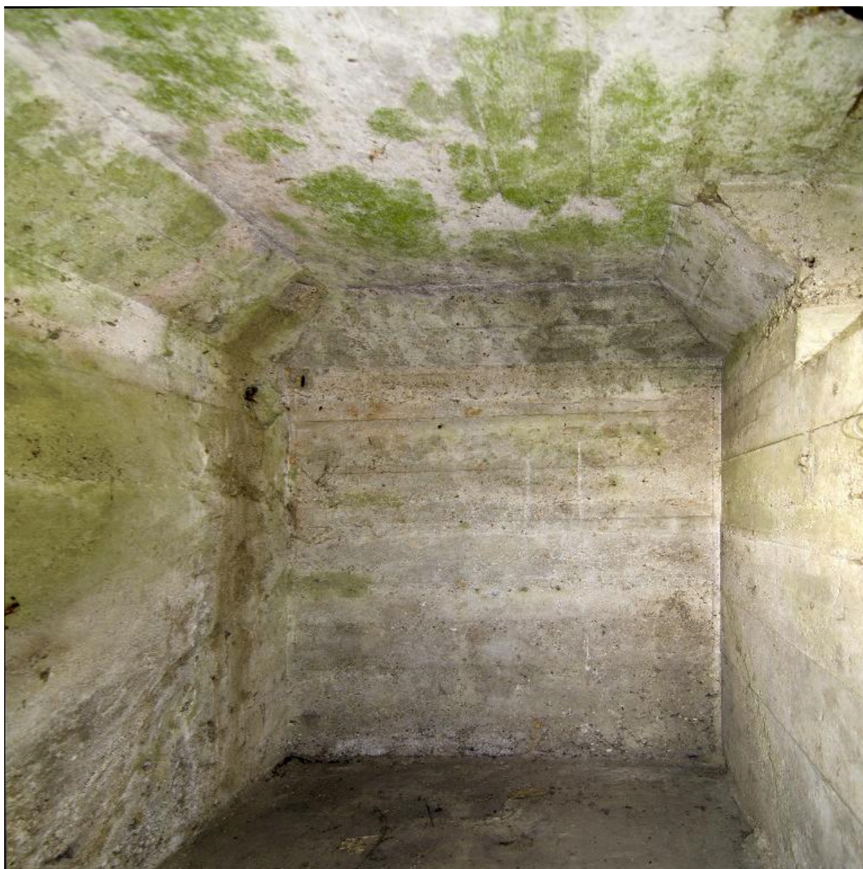
Guérite casematée (Bat. A). Vue intérieure du mur nord (au grand angle)
