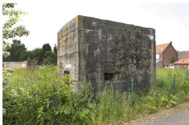
Guerite casematée (Bat. A) vers le nord ouest Phot. Jean-Marc Ramette IVR31_20145904723NUCA
