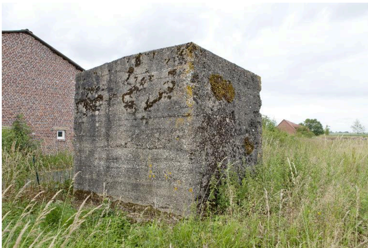
Guérite casematée (Bat. A). Vue de trois-quarts arrière, vers sud-est
