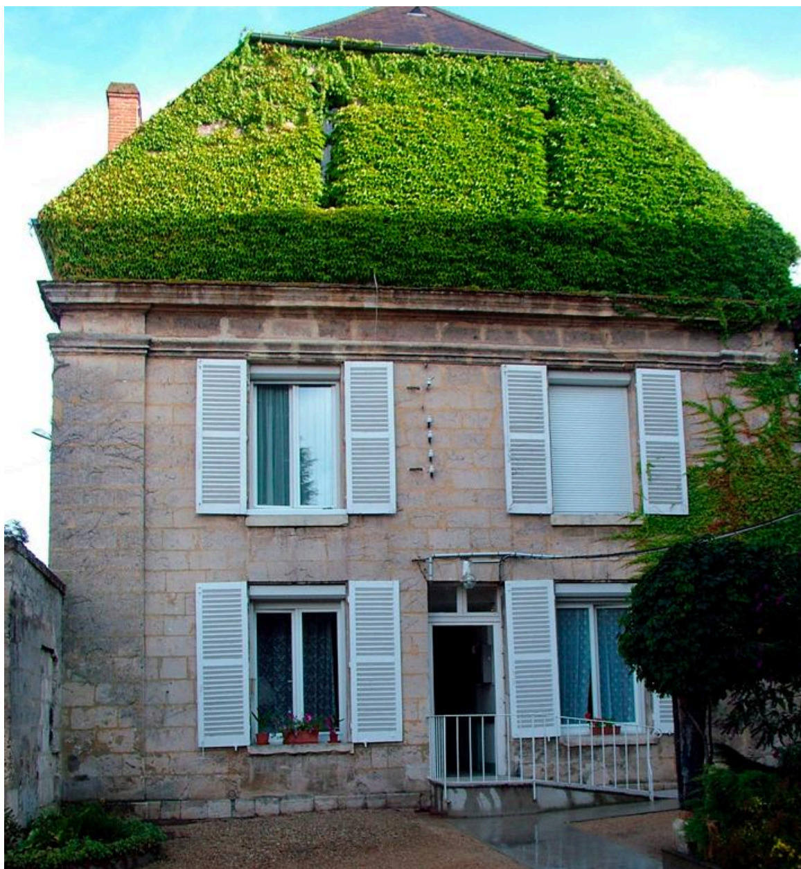
Vue du pignon d'un pavillon annexe.
