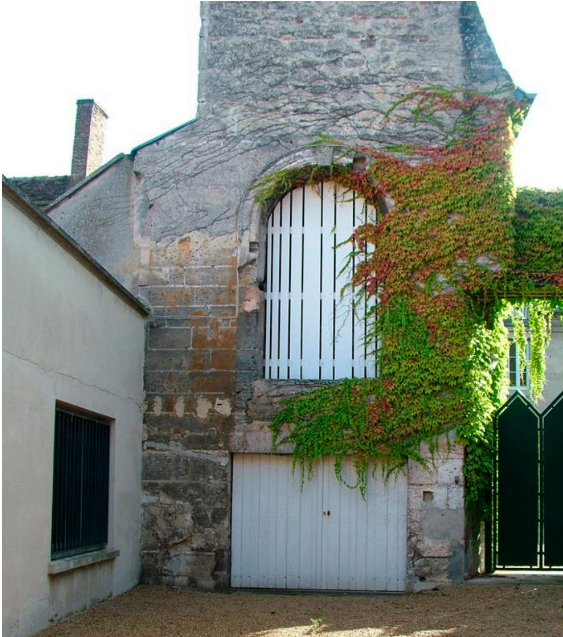
Vestiges de l'élévation de l'ancienne église prieurale.
