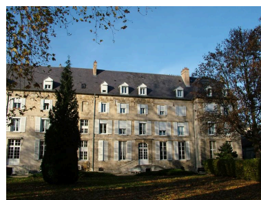
Vue du corps principal du logis prieural, depuis le jardin. Phot. Frédéric Fournis IVR22_20040202677NUC2A
