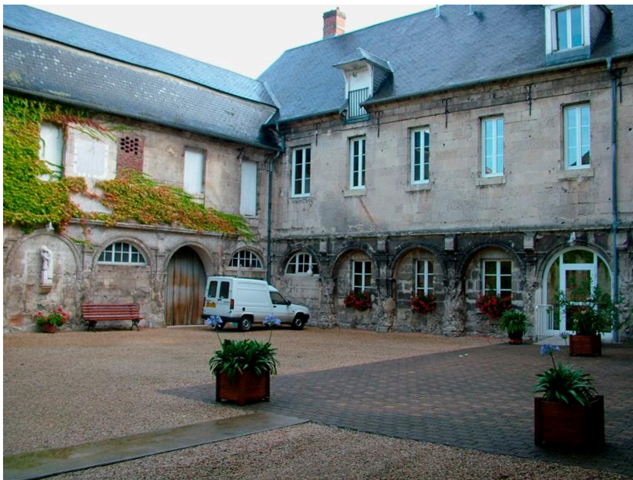
Vue partielle du cloître.
