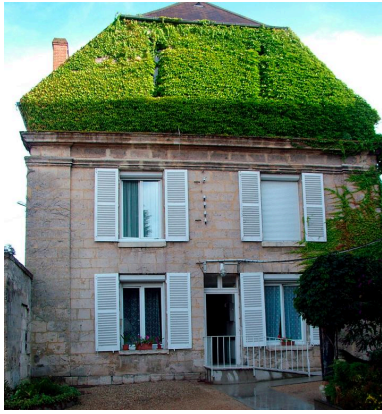
Vue du pignon d'un pavillon annexe.
