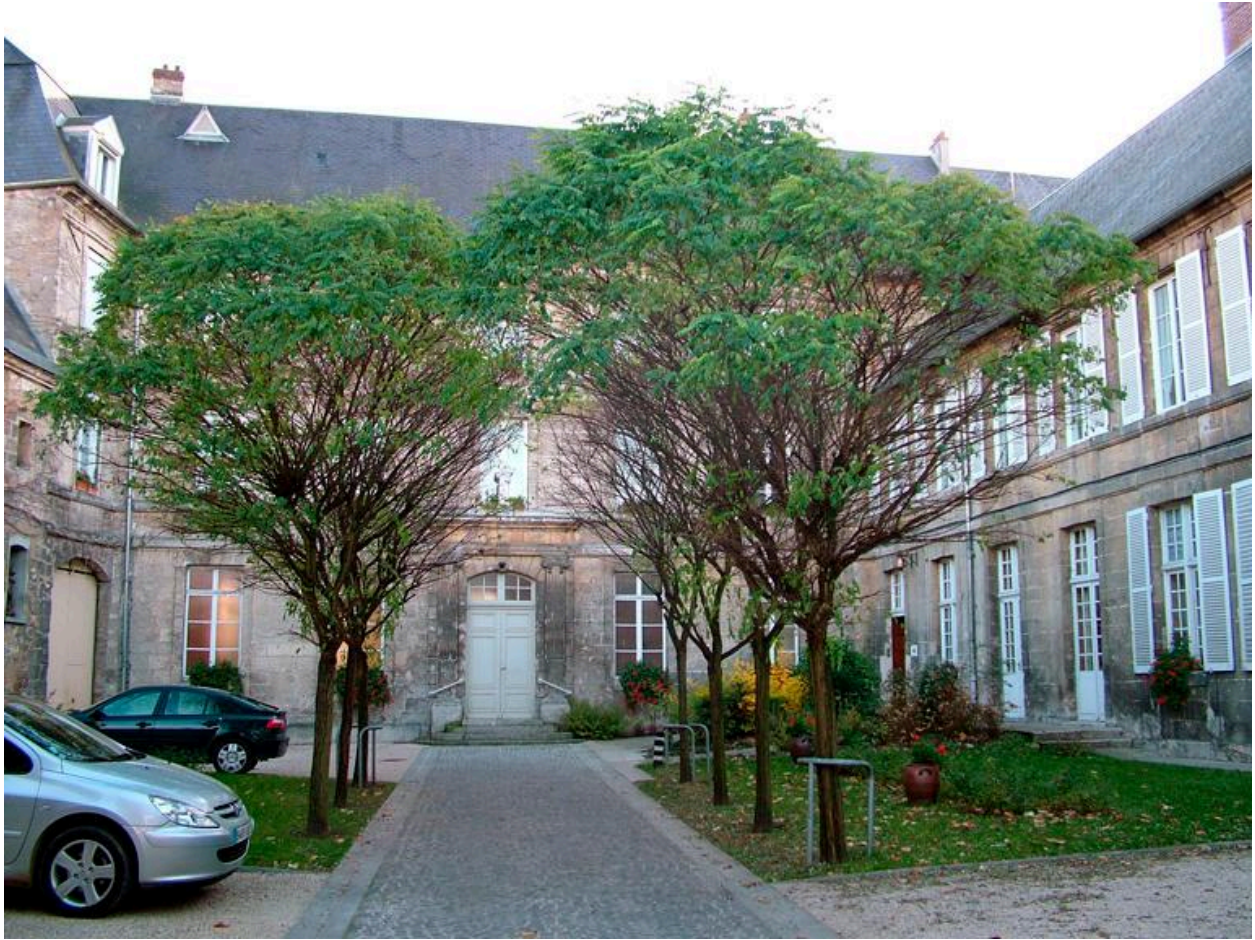
Vue partielle du logis prieural sur cour.
