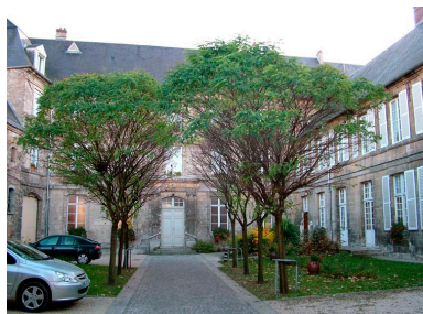
Vue partielle du logis prieural sur cour. Phot. Frédéric Fournis IVR22_20040202676NUC2A
