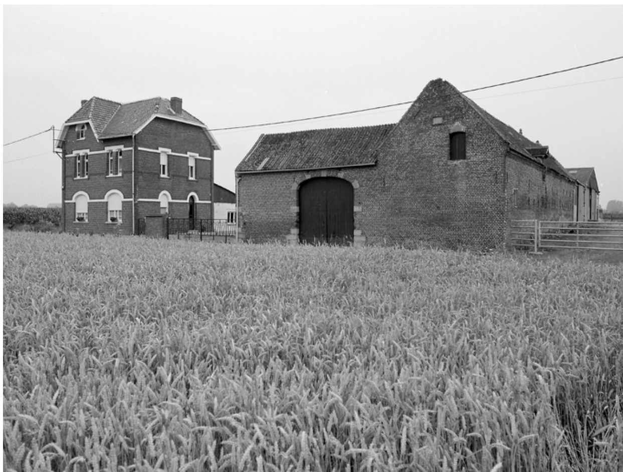
Vue générale de trois quarts : logis, passage charretier et étables-écuries.
