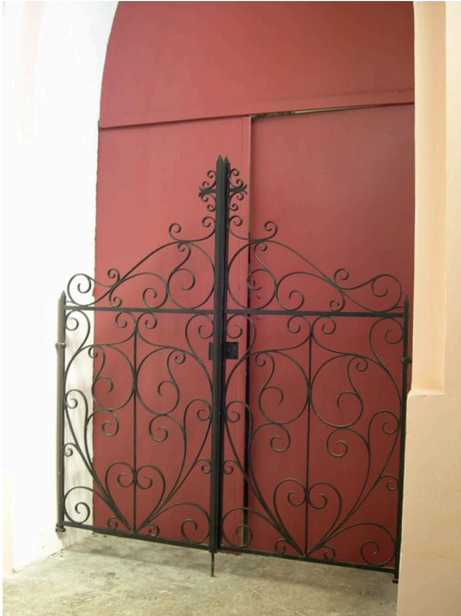
Grille fermant les pièces attenantes au vestibule.
