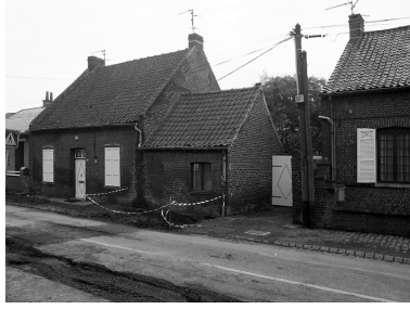
Vue générale. Phot. Philippe Dapvril IVR31_20045900654X
