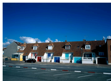
Ensemble de cinq maisons accollées, digue sud. Phot. Marie-Laure Monnehay-Vulliet IVR22_20038001059XA
