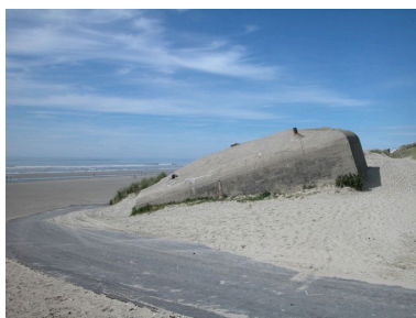
Un blockhaus au sud de la digue. Phot. Elisabeth Justome IVR22_20058003988NUCA
