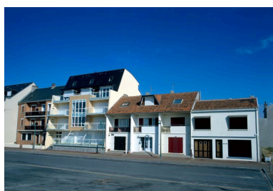
Les constructions de la digue nord. Phot. Marie-Laure Monnehay-Vulliet IVR22_20038001061XA
