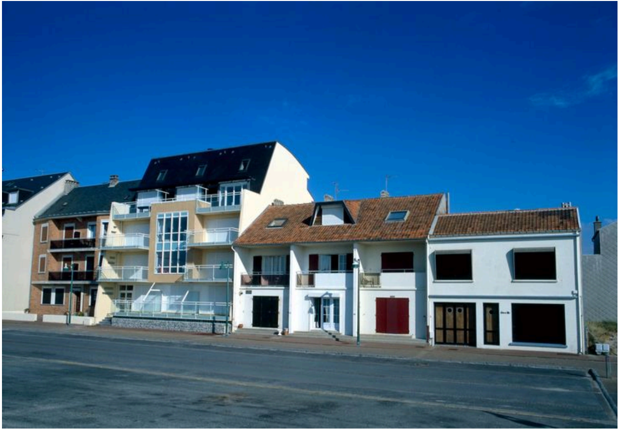
Les constructions de la digue nord.
