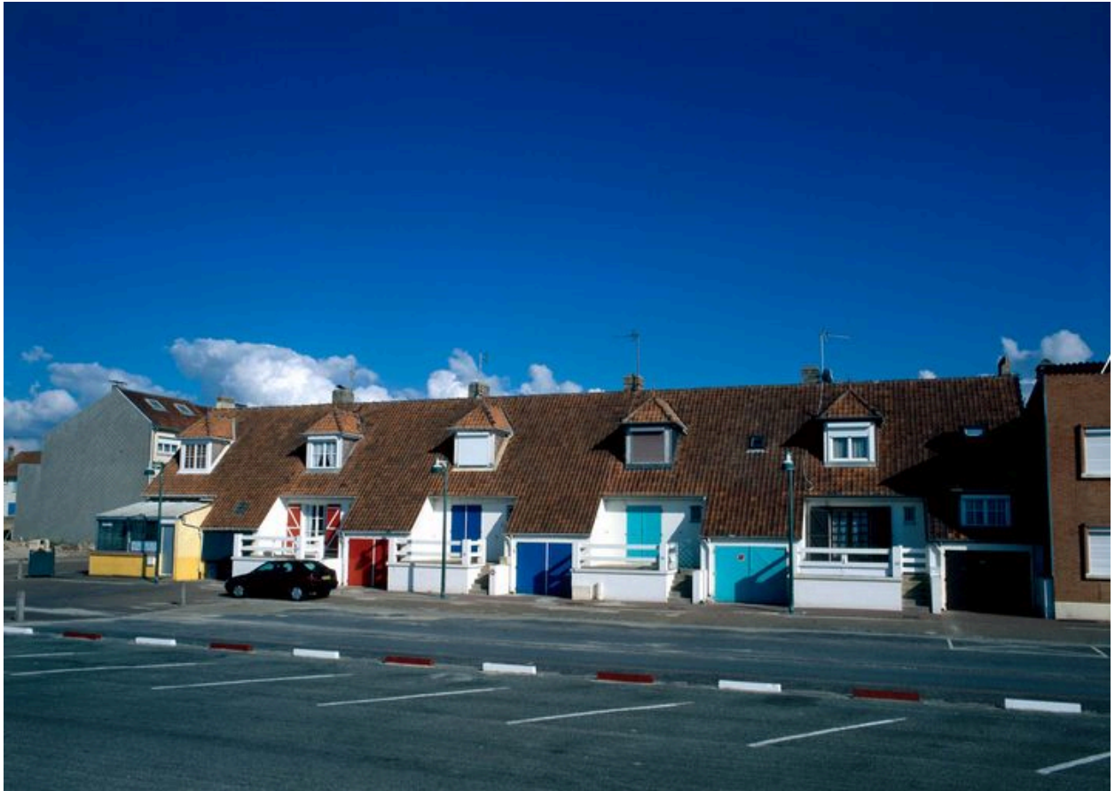
Ensemble de cinq maisons accolées, digue sud.
