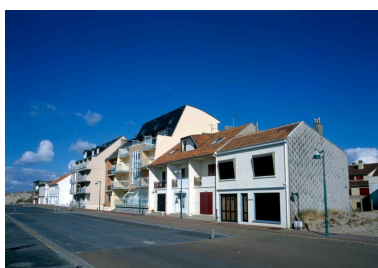
Les constructions de la digue nord. Phot. Marie-Laure Monnehay-Vulliet IVR22_20038001060XA
