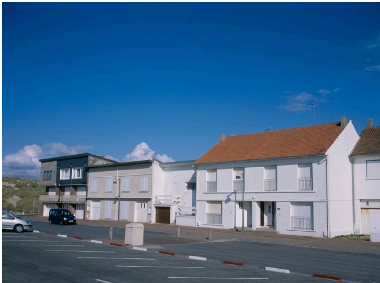
Les dernières habitations de la digue nord.
