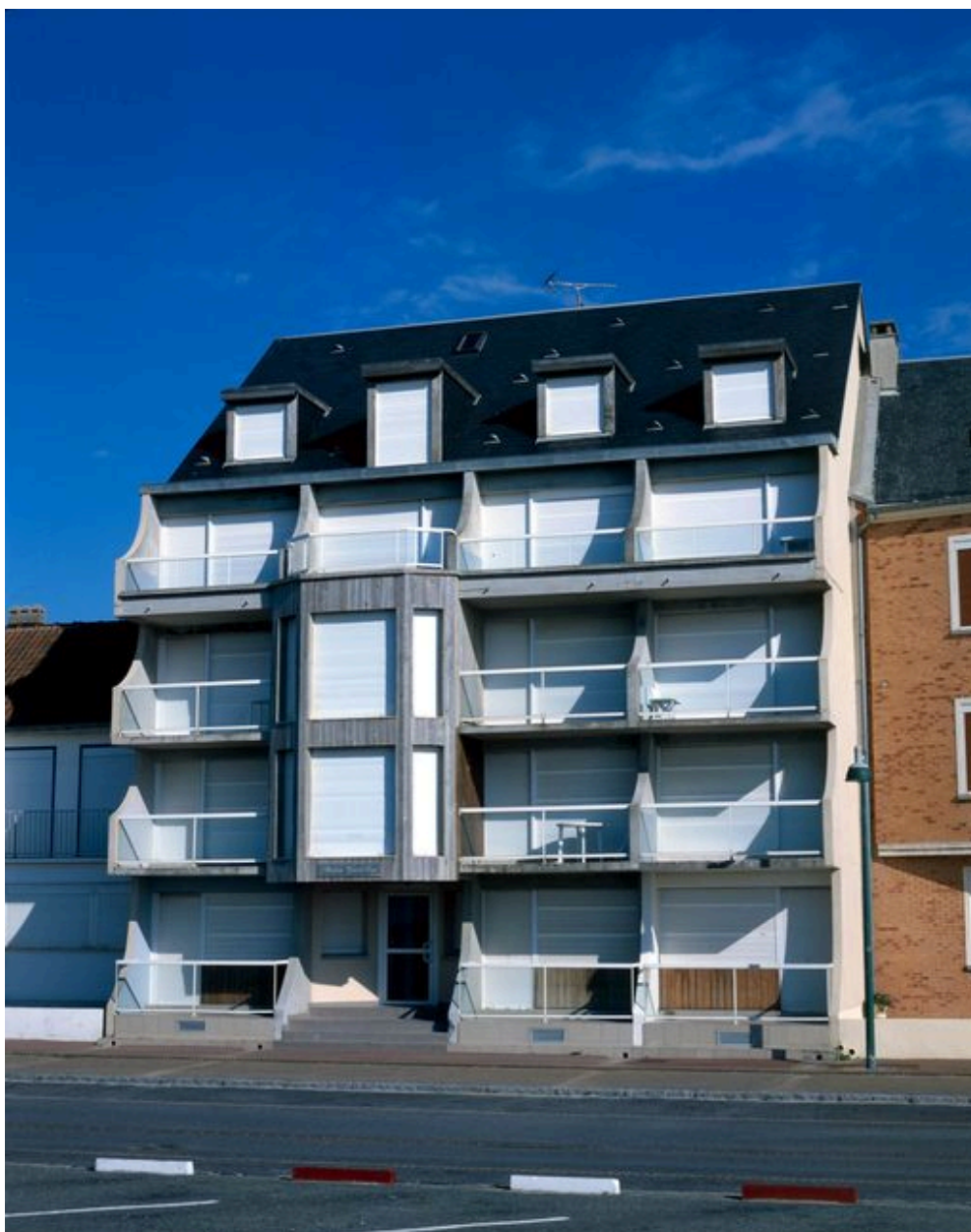
Immeuble du 4e quart du 20e siècle, digue nord.
