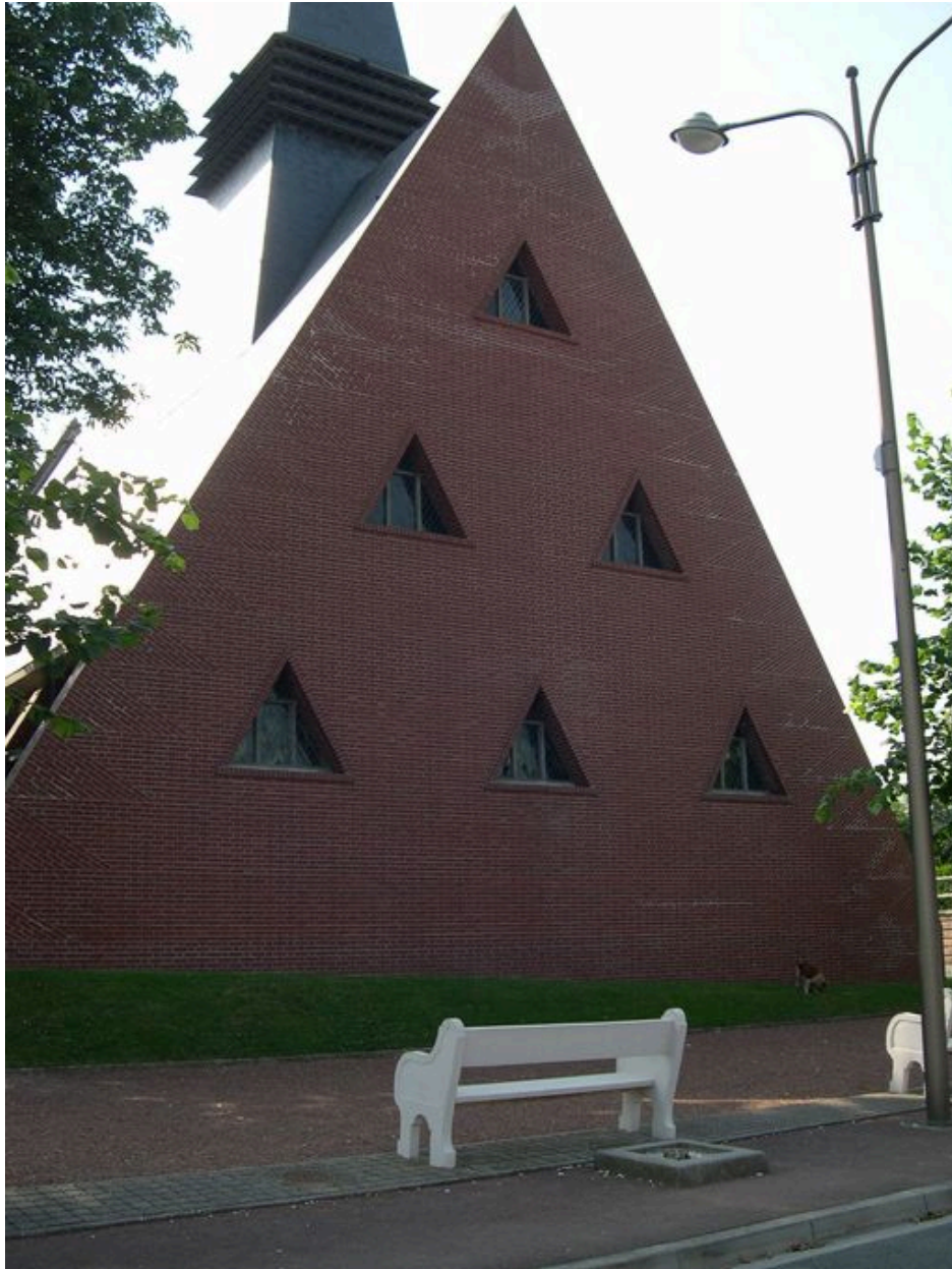
Vue du pignon oriental.
