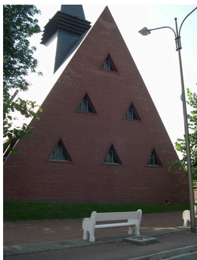
Vue du pignon oriental. Phot. Isabelle Barbedor IVR22_20068010024NUCA
