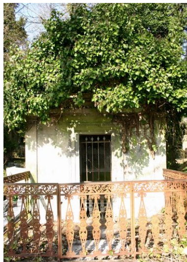
Vue de face du tombeau en forme de chapelle. Phot. Caroline Vincent IVR22_20098000922NUCA
