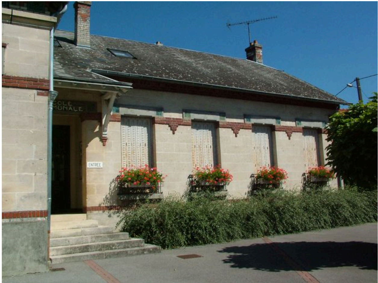
Vue des bâtiments scolaires.
