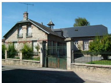
Vue latérale du logement de l'instituteur. Phot. Inès Guérin IVR22_20030202474NUCA
