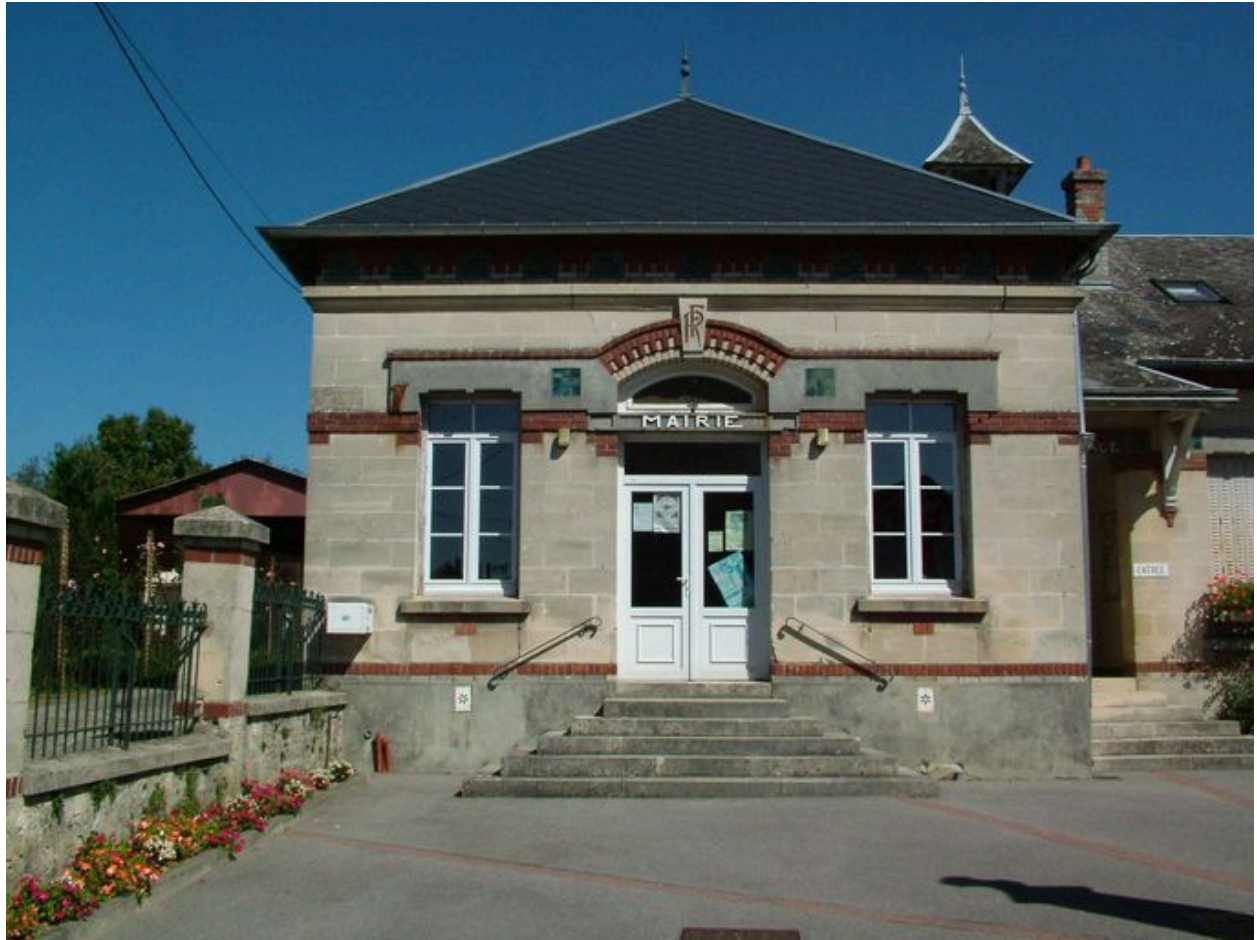
Vue détaillée du bâtiment de la mairie.
