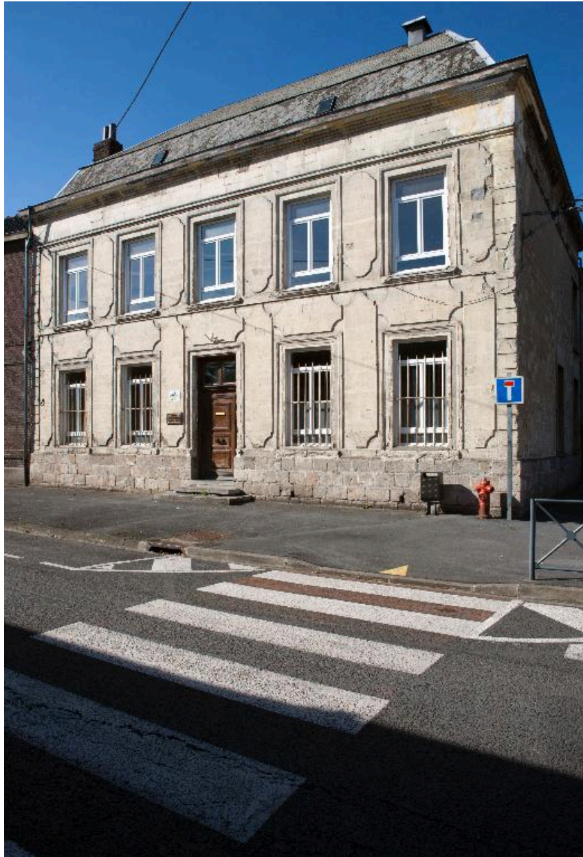
Elévation antérieure de la maison du XVIII e siècle abritant actuellement les bureaux de l'école maternelle Notre Dame des Anges
