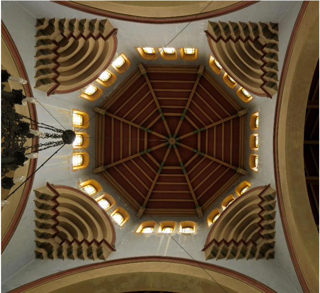
Vue de la coupole.
