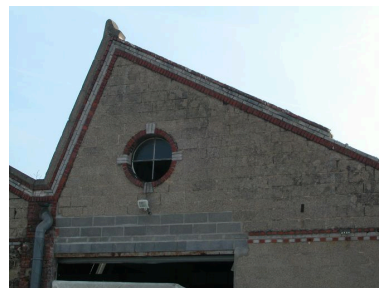
Façade ouest de l'atelier de fabrication, détail d'un des pignons en shed. Phot. Thierry Lefébure IVR22_20036000170NUCA
