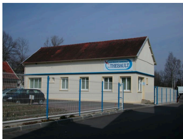
Les anciens bureaux. Phot. Thierry Lefébure IVR22_20036000174NUCA
