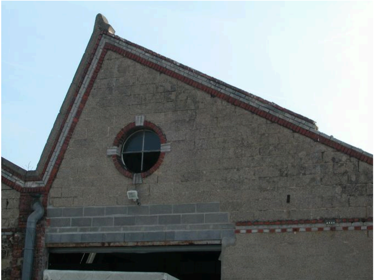
Façade ouest de l'atelier de fabrication, détail d'un des pignons en shed.
