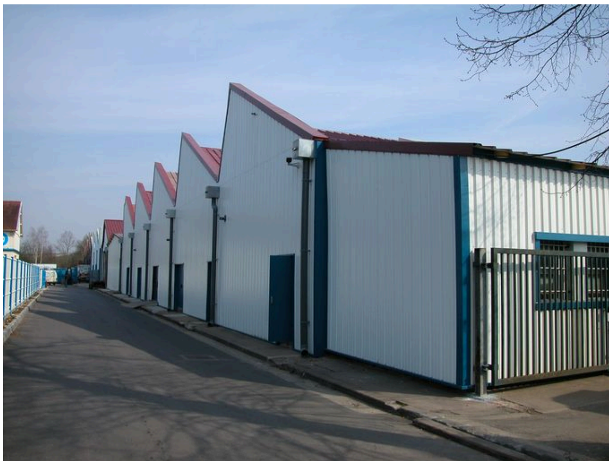
Façade ouest de l'atelier de fabrication.
