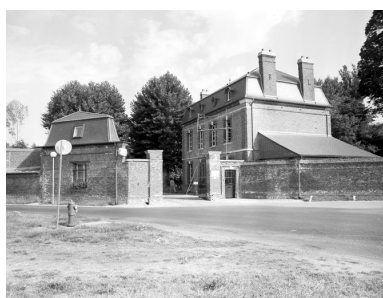
Le logement patronal et la conciergerie situés à l'entrée de l'usine, en 1999. Phot. Laurent Jumel IVR22_19966002499X
