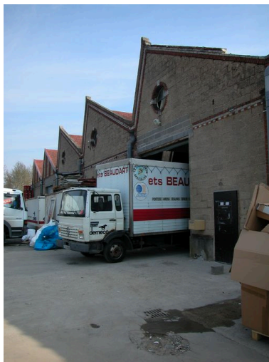
Façade ouest des dernières travées de l'atelier de fabrication, vue de trois-quarts. Phot. Thierry Lefébure IVR22_20036000169NUCA
