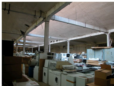
Intérieur de l'atelier de fabrication, détail des charpentes en béton armé. Phot. Thierry Lefébure IVR22_20036000173NUCA
