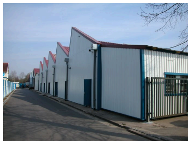
Façade ouest de l'atelier de fabrication. Phot. Thierry Lefébure IVR22_20036000171NUCA
