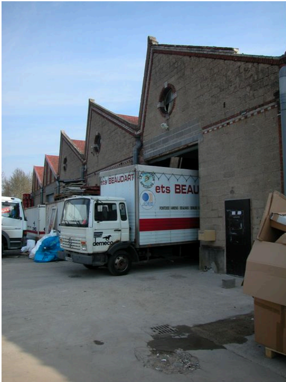
Façade ouest des dernières travées de l'atelier de fabrication, vue de trois-quarts.
