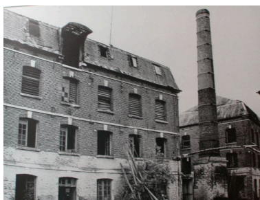
Vue des bâtiments de la filature avant leur destruction, 1982. Phot. Fournier Bertrand (reproduction), Autr. Francis Dubuc IVR22_20036000581NUCAB
