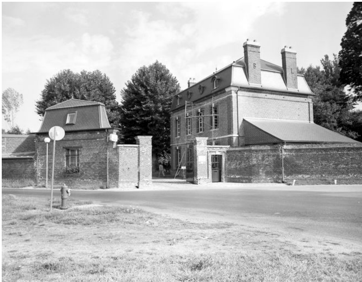
Le logement patronal et la conciergerie situés à l'entrée de l'usine, en 1999.
