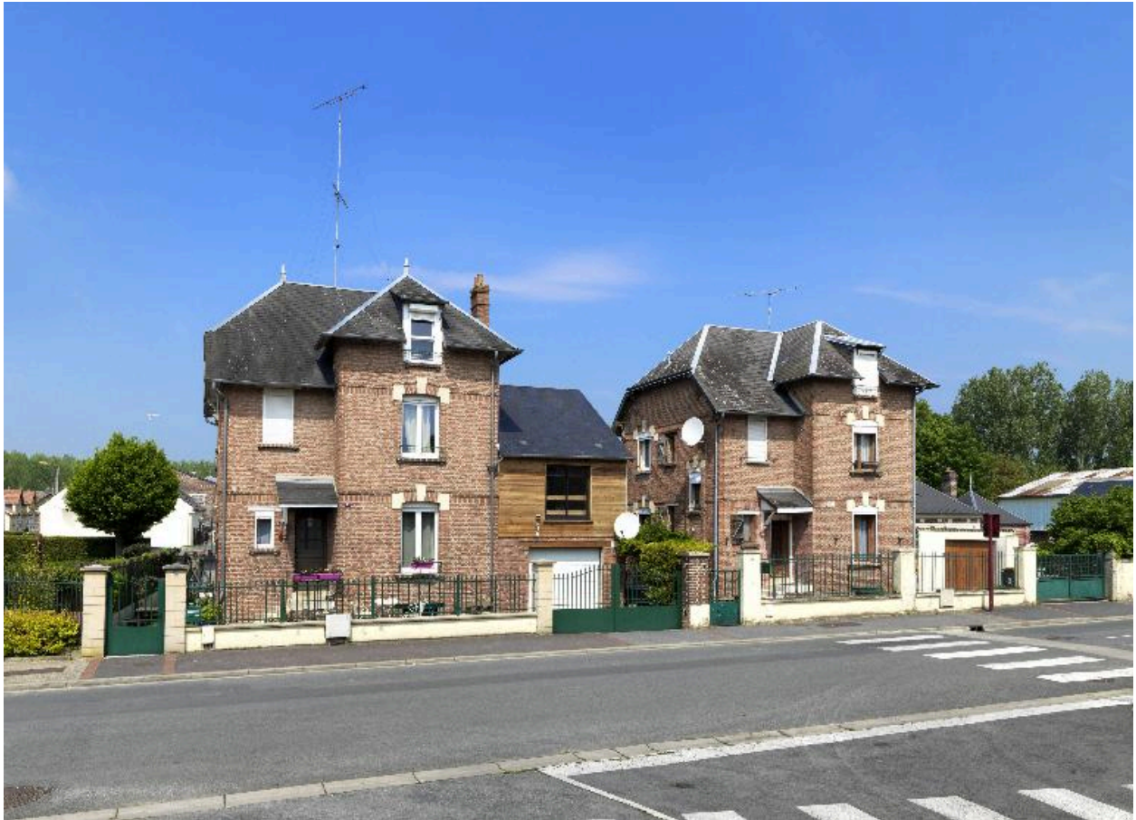
Vue d'ensemble sur rue des deux maisons d'ingénieur.
