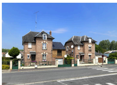
Vue d'ensemble sur rue des deux maisons d'ingénieur. Phot. Thierry Lefébure IVR32_20160200039NUC2A
