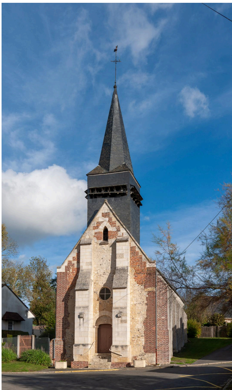
Façade occidentale de l'église Saint-Sauveur.
