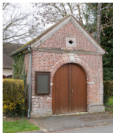
Ancienne remise des pompes à incendie, rue des Merisiers. Phot. Marc Kérignard IVR32_20236000280NUCA
