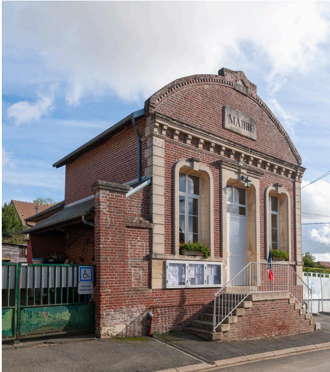
Mairie, vue depuis le nord-ouest.
