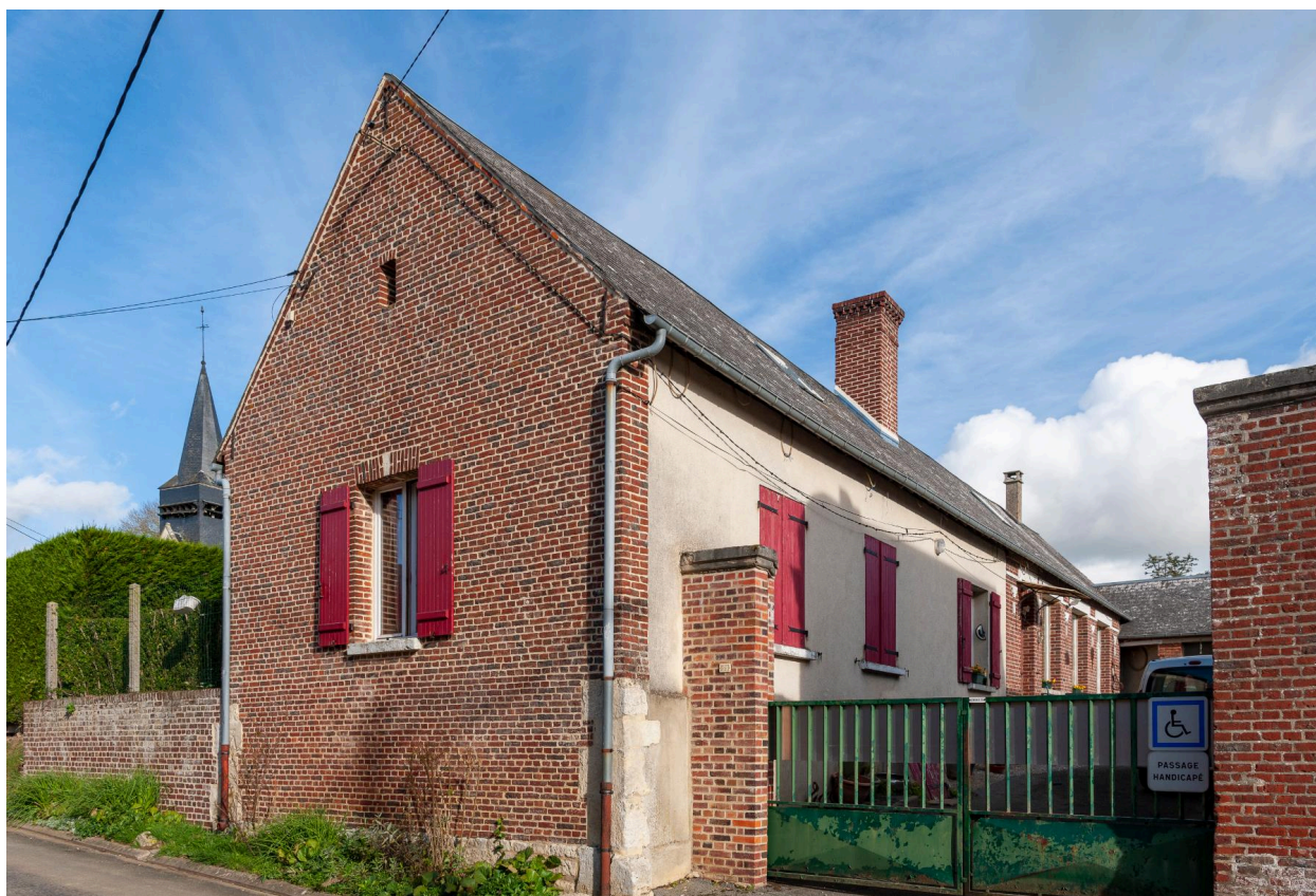
Ancienne école, vue depuis le sud-ouest.
