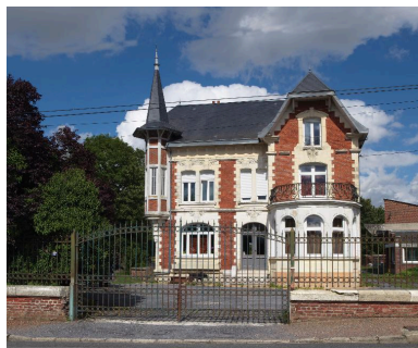
Maison, 17 rue Joliot-Curie. Phot. Marie-Laure Monnehay-Vulliet IVR22_20158000697NUC2A
