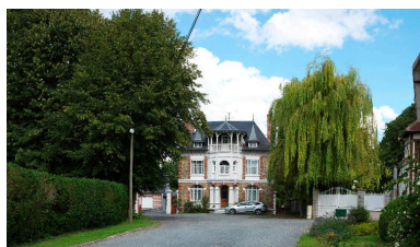
Maison, 35 rue Joliot-Curie. Phot. Marie-Laure Monnehay-Vulliet IVR22_20158000700NUC2A
