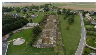
Vue aérienne oblique et longitudinale, vers le sud-ouest. Phot. Marc Kérignard IVR32_20226200283NUCA
