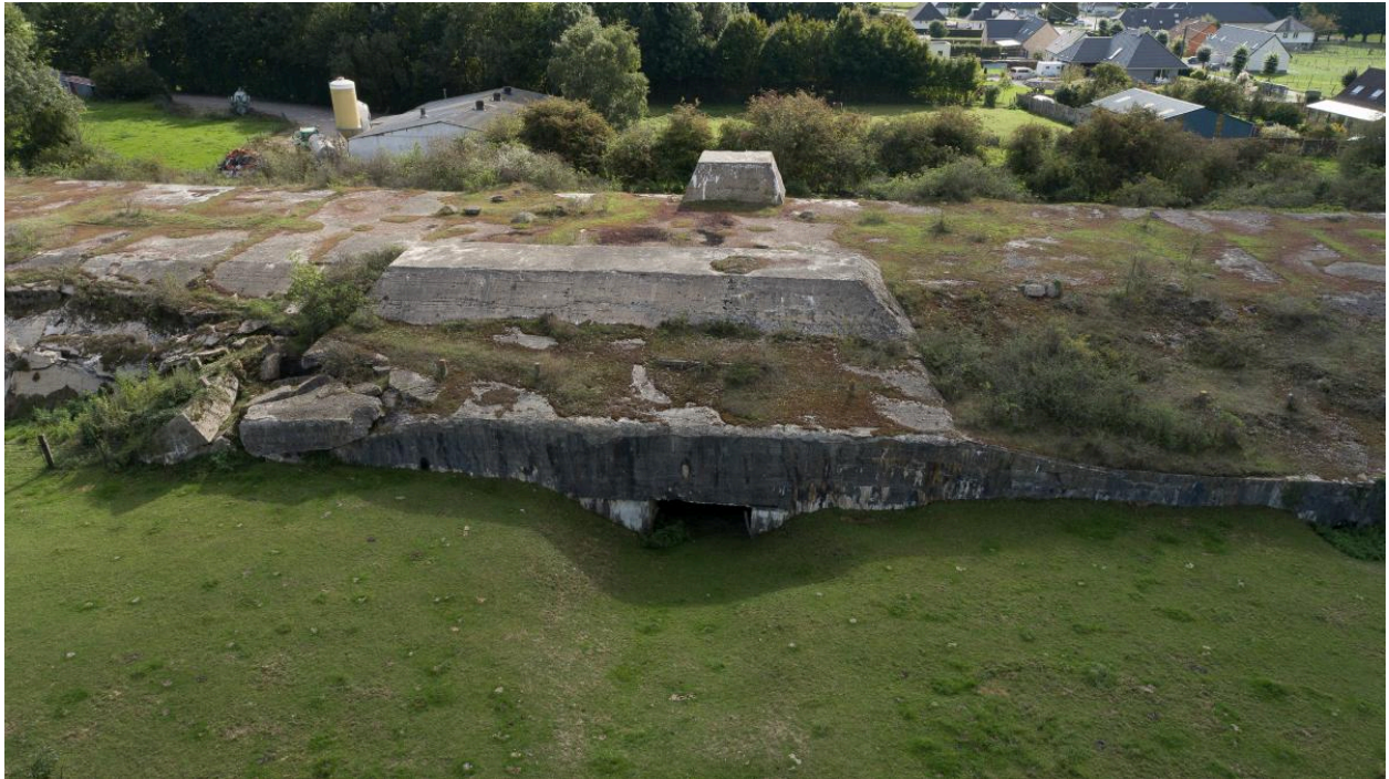
Vue aérienne de la partie centrale, vers le sud-est. Sortie de la catapulte de lancement.
