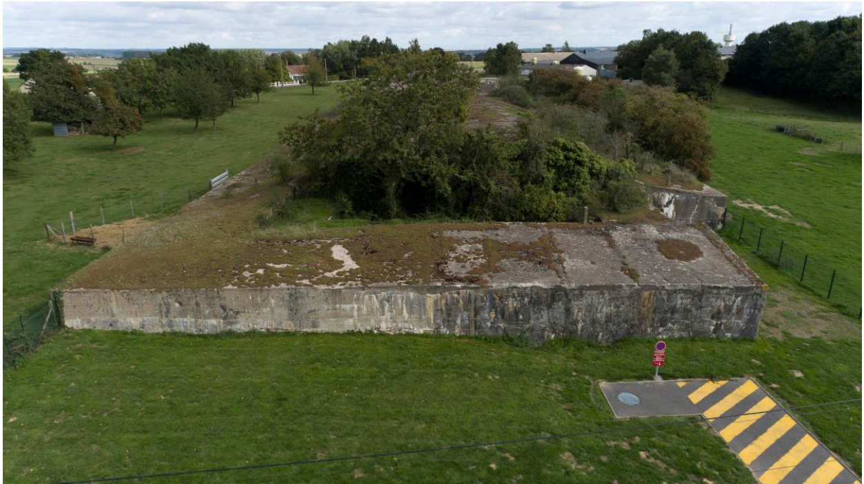
Vue aérienne oblique et longitudinale, vers le nord-est.
