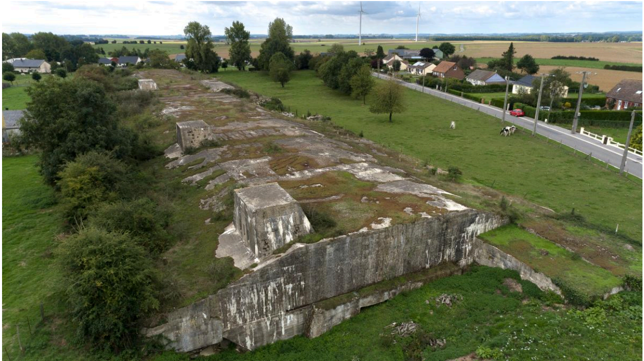
Vue aérienne oblique vers le nord.
