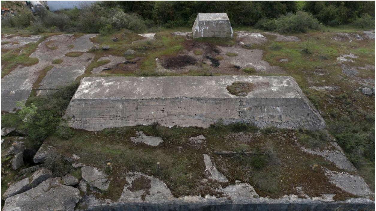
Vue aérienne oblique de l'élévation nord-ouest. Détail de la couverture de sortie de la rampe de catapultage.
