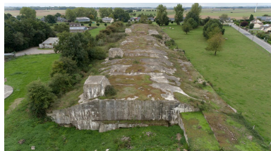
Vue aérienne oblique et longitudinale vers le sud-ouest. Phot. Marc Kérignard IVR32_20226200285NUCA
