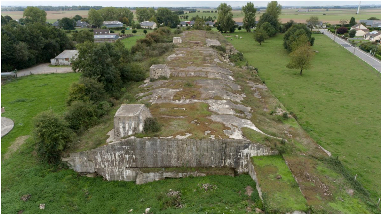
Vue aérienne générale oblique vers le sud-ouest.
