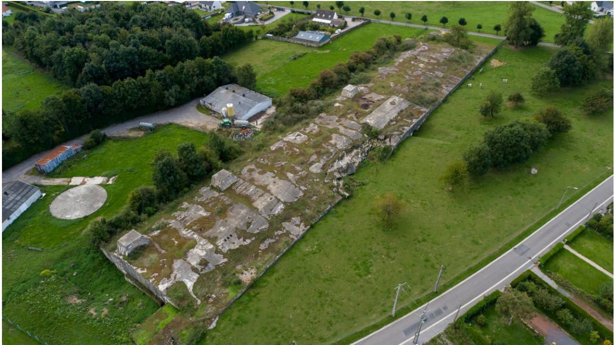
Vue aérienne plongeante vers le sud. Au centre, la partie effondrée de la sortie de la rampe de catapultage.
