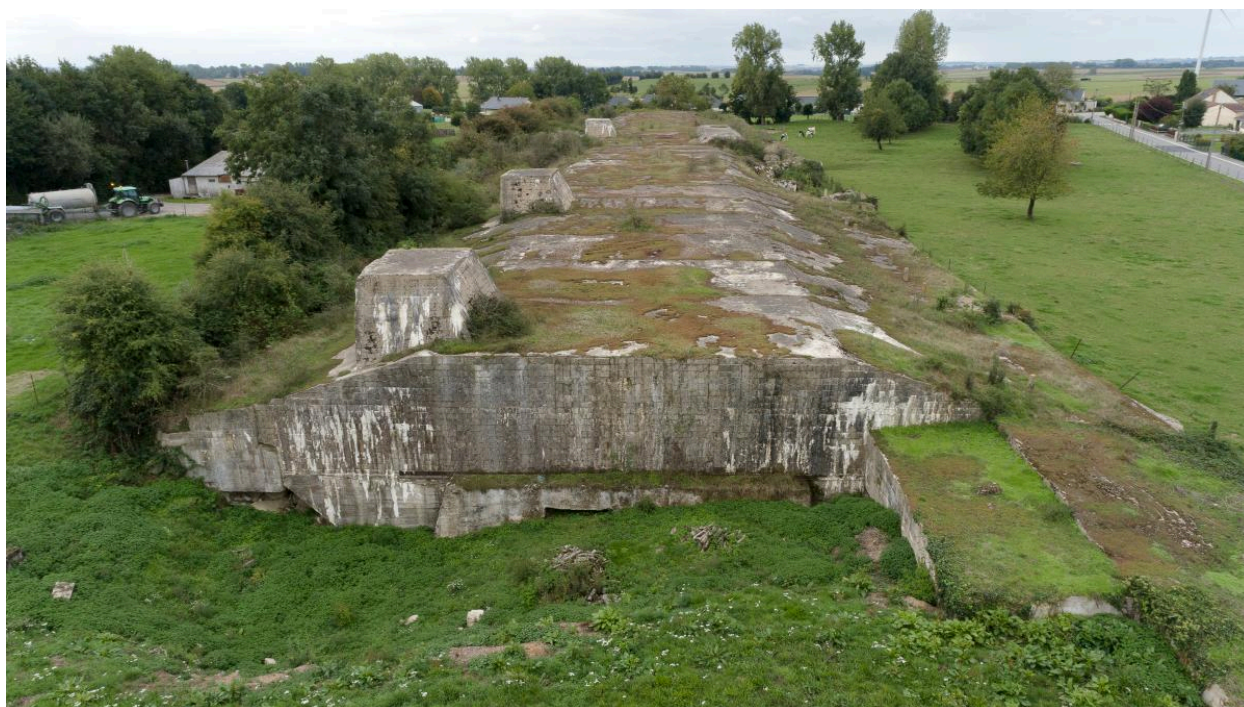
Vue aérienne longitudinale oblique vers le sud-ouest.
