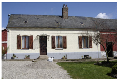
Vue du logis. Phot. Inès Guérin IVR22_20058005564NUCA
