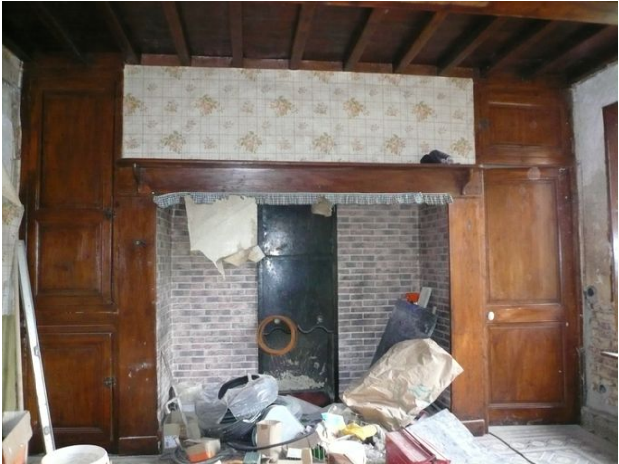
Vue d'une cheminée picarde flanquée de part et d'autre de placards intégrés et d'une porte donnant accès à la chambre.
