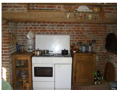
Autre exemple de cheminée entièrement en brique, avec four à pain, cafourneau et tablette à étage.
