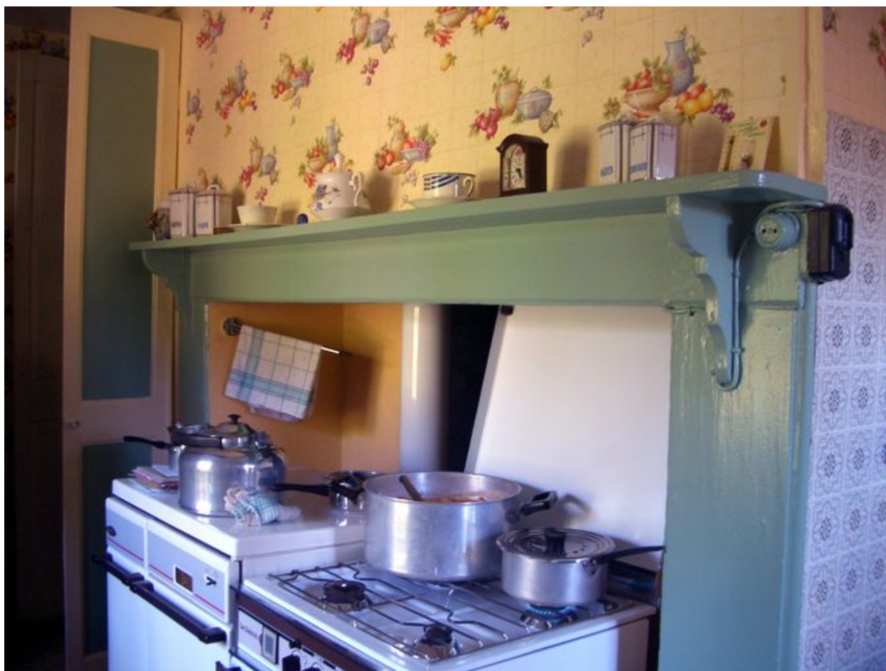
Vue d'une cheminée traditionnelle avec tablette supportée par deux corbeaux sculptés ; aménagement moderne pour la cuisine.
