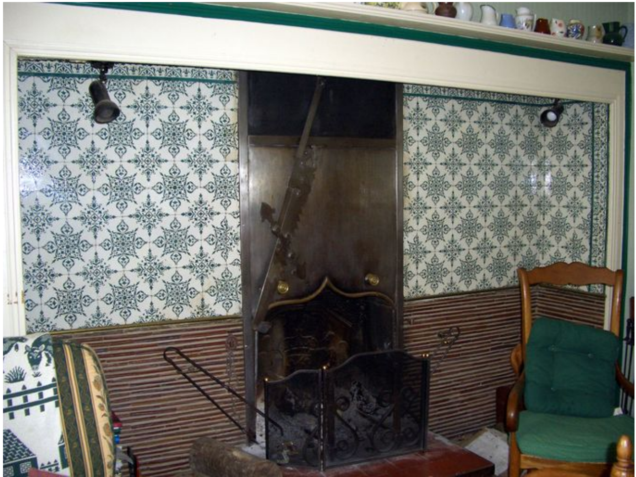
Vue d'une cheminée traditionnelle avec carreaux de céramique et foyer à la prussienne.
