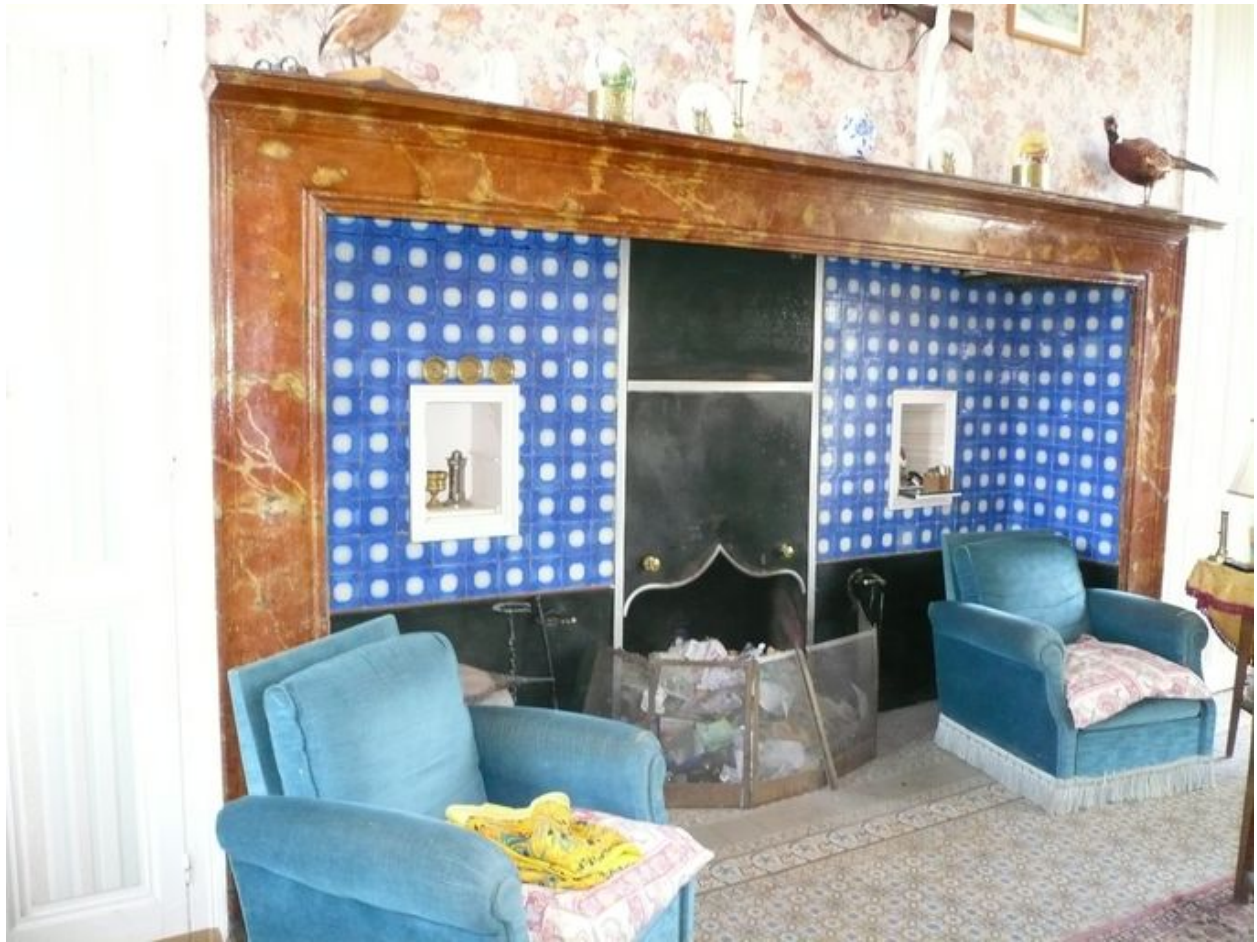
Vue d'une cheminée ayant conservé ses carreaux de Vron, ses deux niches et son système de foyer à la prussienne.
