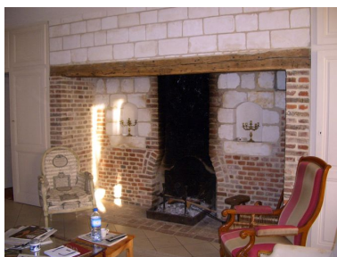
Exemple de cheminée de construction soignée, composée de moellons de pierre calcaire et jambes de brique, percée de deux niches cintrées et d'un foyer à conduit.
