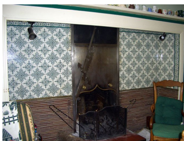
Vue d'une cheminée traditionnelle avec carreaux de céramique et foyer à la prussienne.
