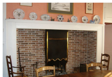
Vue d'une cheminée traditionnelle munie d'un foyer à la prussienne de forme différente. Phot. Inès Guérin IVR22_20058005321NUCA
