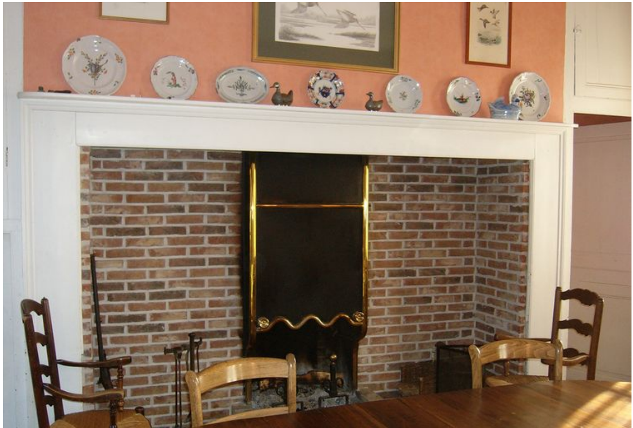
Vue d'une cheminée traditionnelle munie d'un foyer à la prussienne de forme différente.
