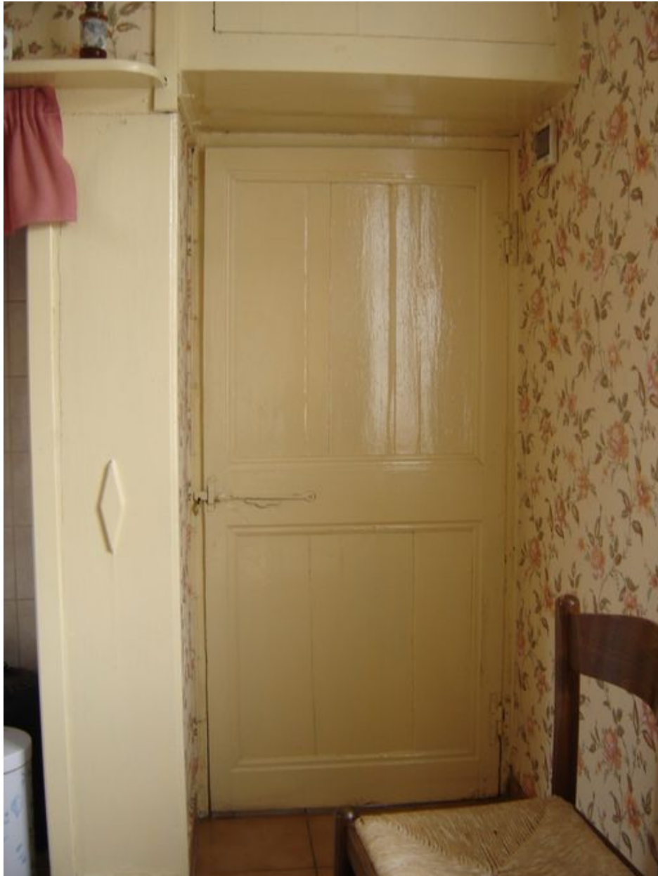
Porte située sous le placard à confiture, à droite de la cheminée, permettant l'accès à la seconde salle ou à une chambre.
