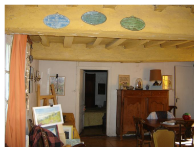
Vue intérieure d'une salle présentant un plafond composé de solives sur poutres maîtresses, le tout peint en jaune, couleur d'origine. Phot. Inès Guérin IVR22_20068005122NUCA
