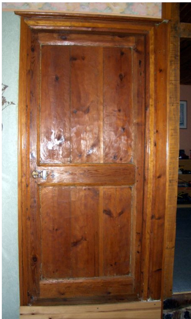
Exemple d'une porte de chambre avec entablement mouluré, taillée à l'herminette.
