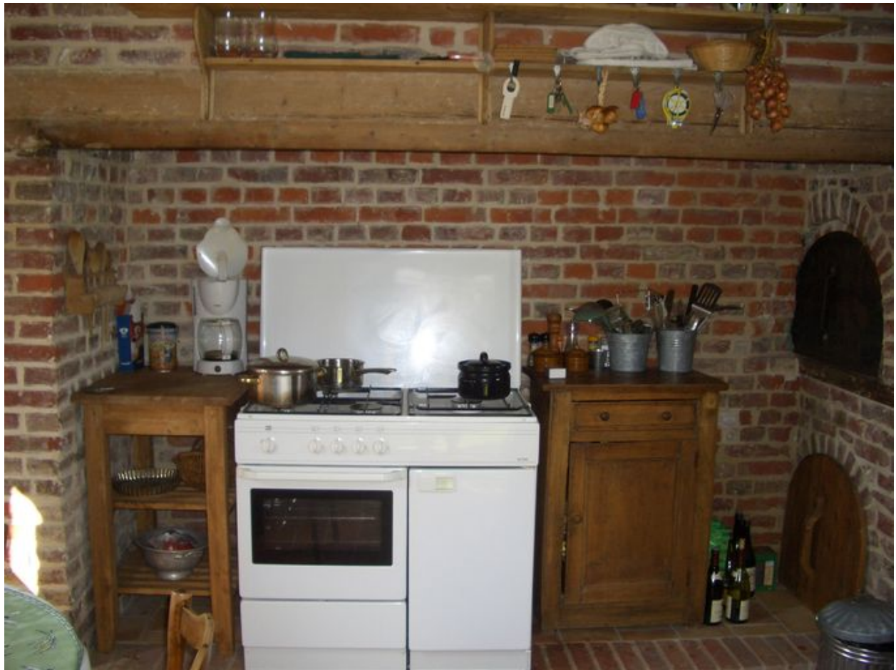
Autre exemple de cheminée entièrement en brique, avec four à pain, cafourneau et tablette à étage.
