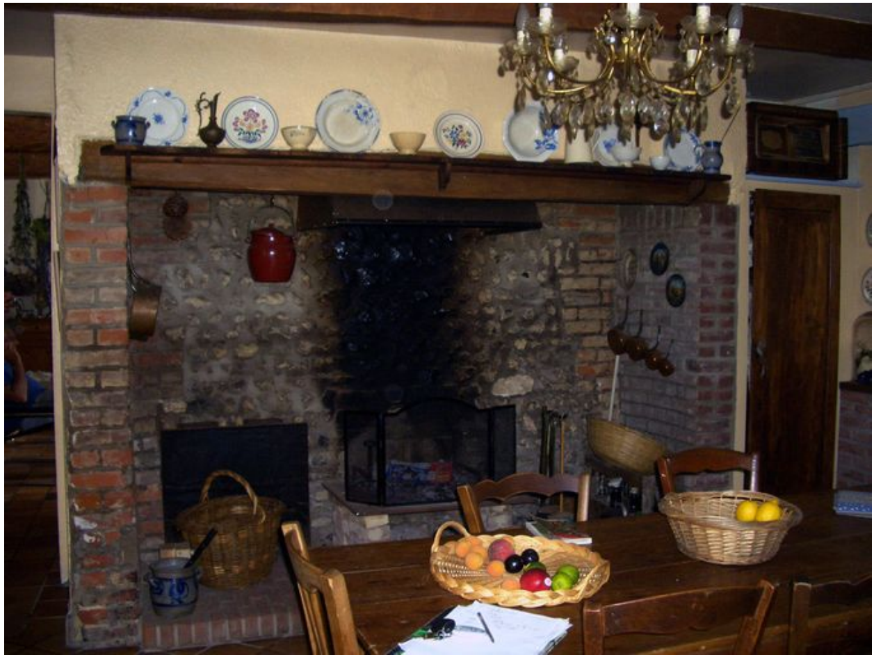
Exemple de cheminée composée d'un blocage de silex avec jambages en brique.
