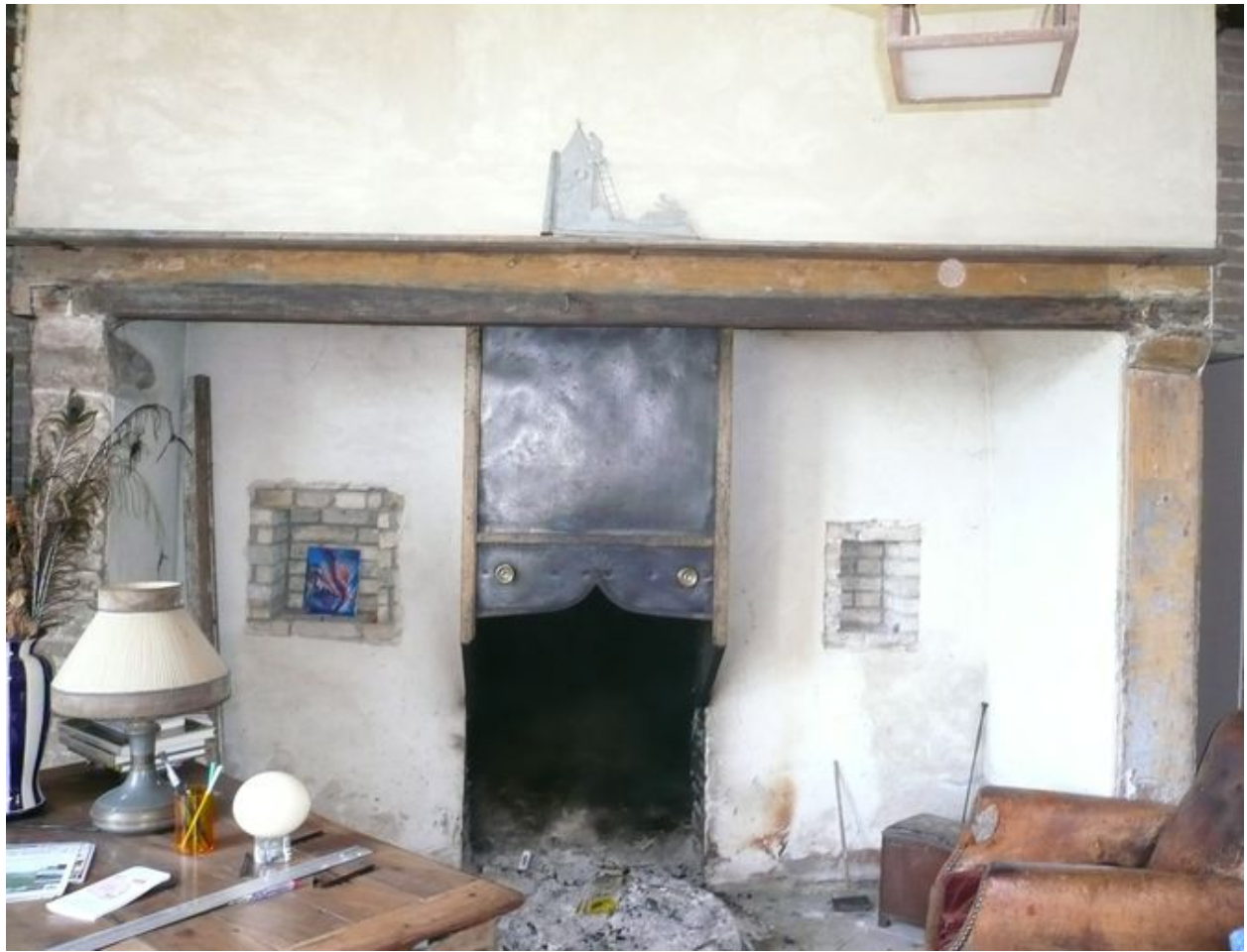
Vue d'une cheminée entièrement en brique avec corbeaux en grés, muni d'un foyer à la prussienne.
