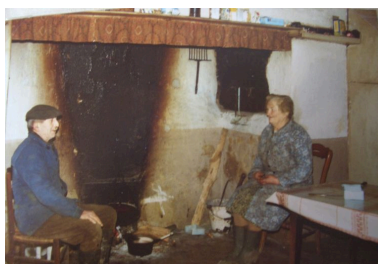
Vue d'un intérieur de maison picarde avec cheminée large. Phot. Inès Guérin IVR22_20078006062NUCAB
