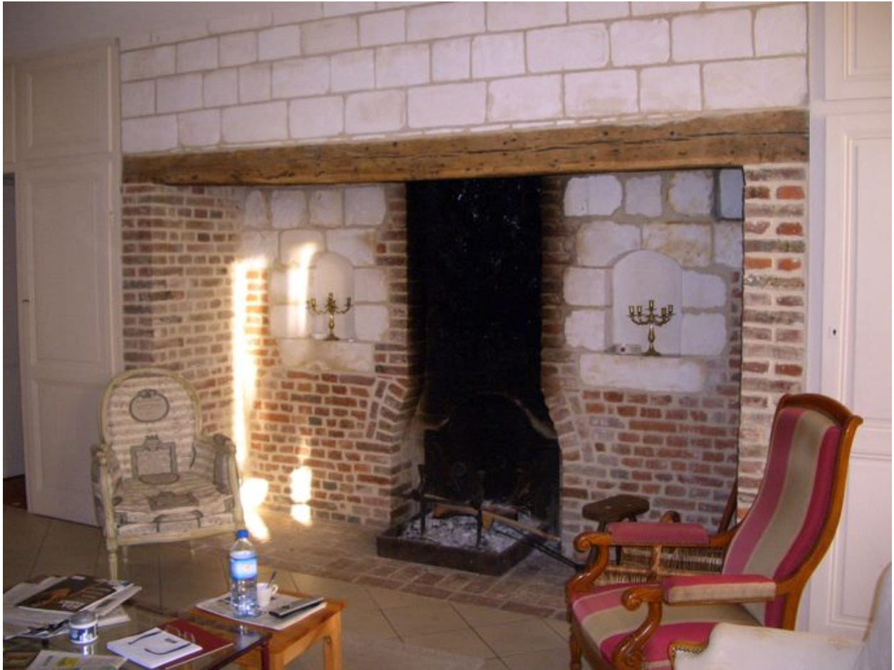
Exemple de cheminée de construction soignée, composée de moellons de pierre calcaire et jambes de brique, percée de deux niches cintrées et d'un foyer à conduit.
