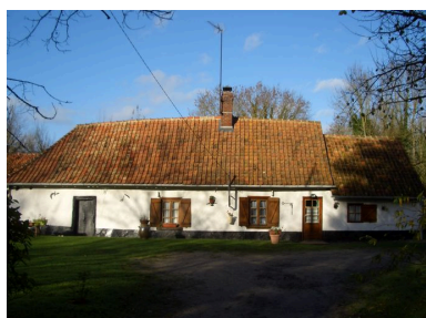
Exemple de maison traditionnelle de l'arrière-pays maritime, avec écurie sous le même toit. Phot. Inès Guérin IVR22_20068005616NUCA
