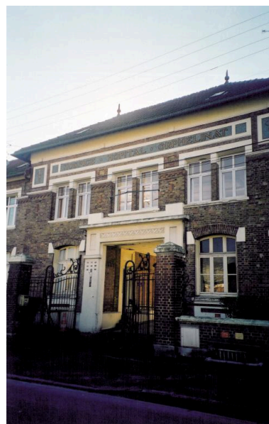
Le bâtiment d'entrée. Phot. Gilles-Henri Bailly IVR22_20158005388NUCA
