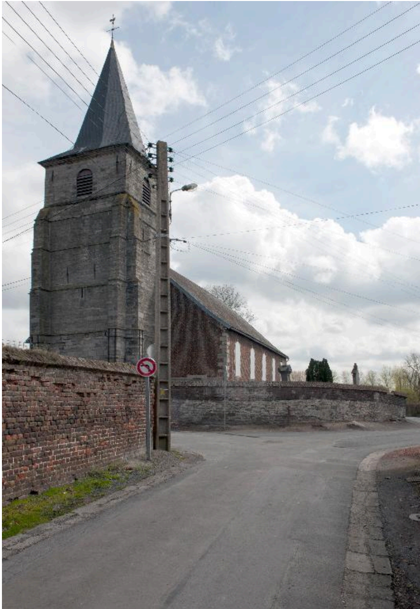
Vue de trois quarts ; clocher et bas-côté sud.
