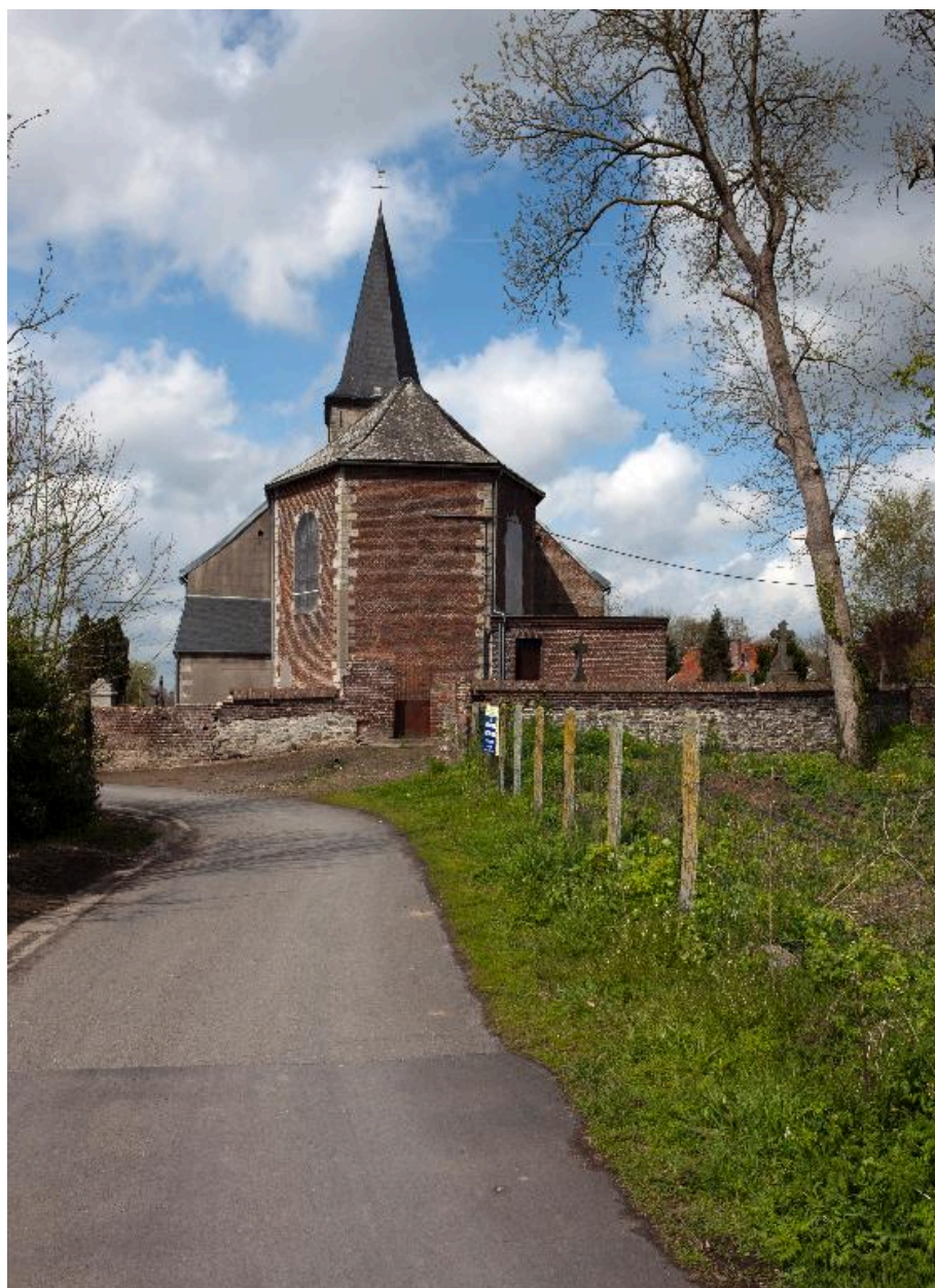
Vue de trois quarts ; clocher et bas-côté sud.
