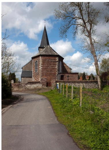
Vue de trois quarts ; clocher et bas-côté sud. Phot. Pierre Thibaut IVR31_20125901673NUCA
