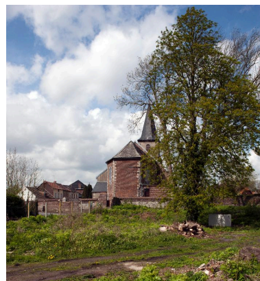
Vue générale du chevet de l'église, entourée du cimetière. Phot. Pierre Thibaut IVR31_20125901676NUCA
