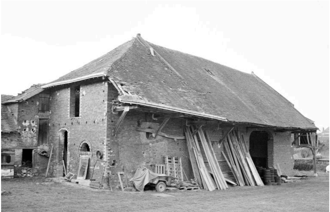
Grange : façade sur cour.
