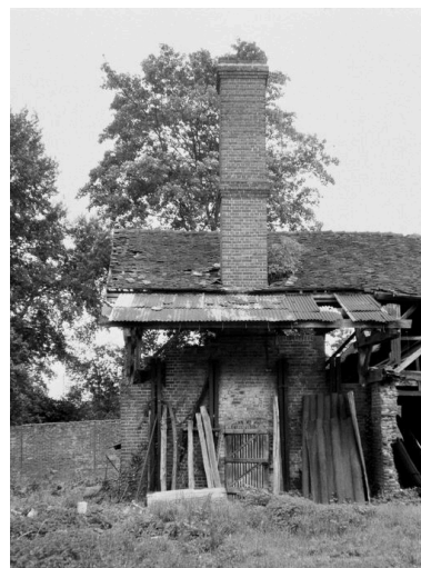
La cheminée carrée avant sa destruction (AP). Phot. Thierry Lefébure IVR22_20006000216XB
