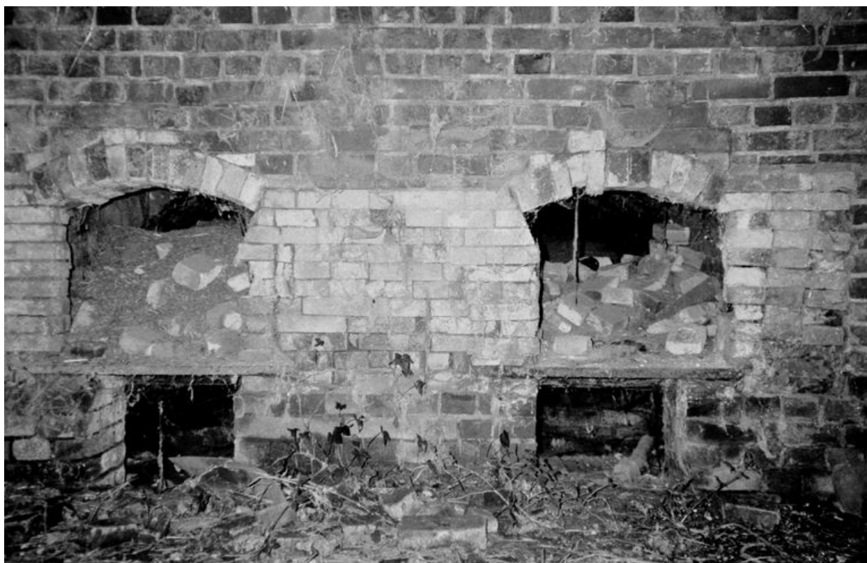
Intérieur du four avant son démontage : détail des cavités d'enfournement (AP).
