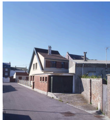
Vue d'ensemble depuis l'impasse Sainte-Catherine.
