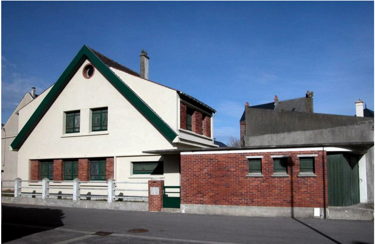
Vue rapprochée de l'habitation et du garage, depuis l'impasse Sainte-Catherine.
