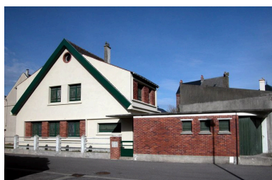
Vue rapprochée de l'habitation et du garage, depuis l'impasse Sainte-Catherine.
