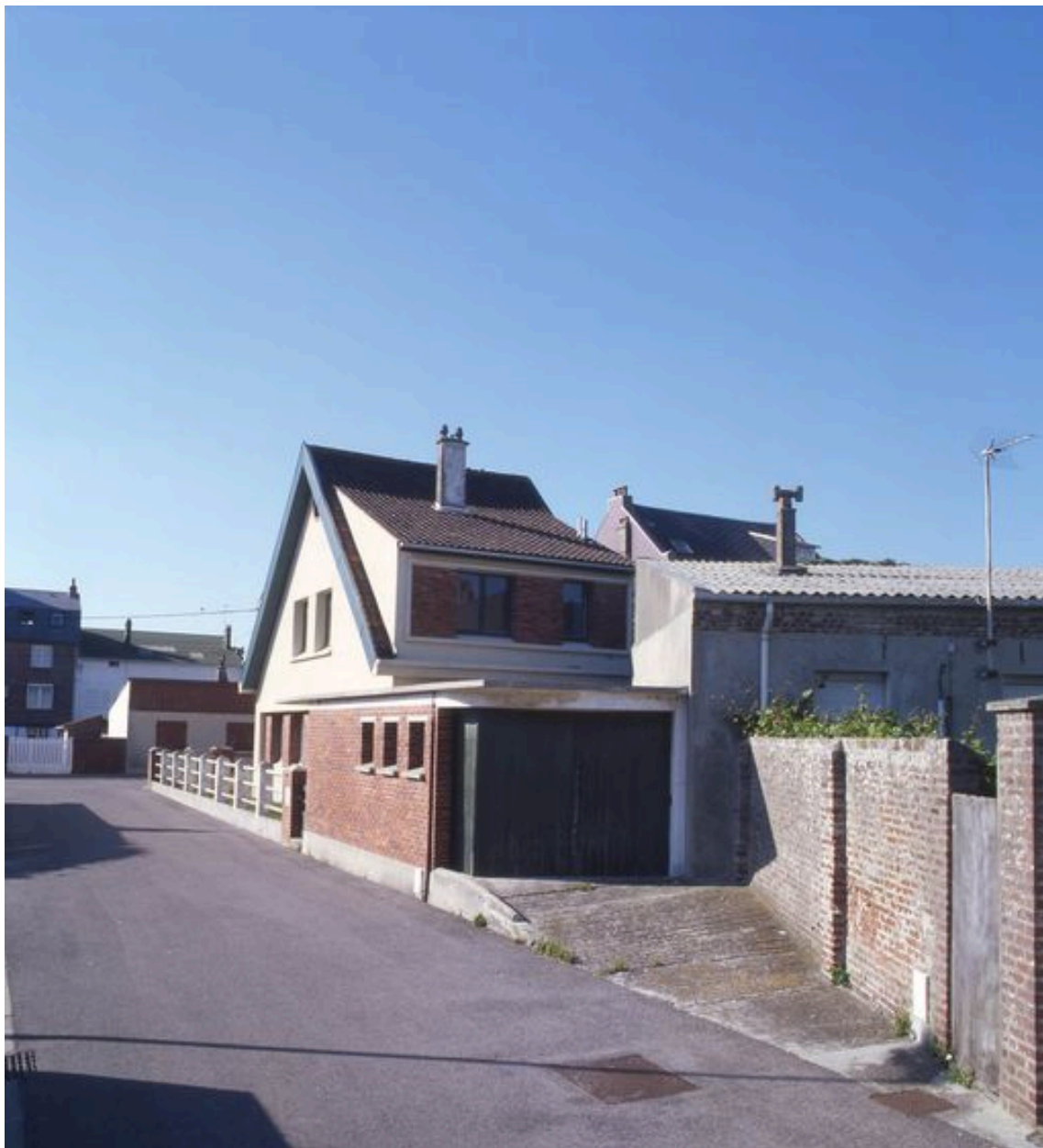
Vue d'ensemble depuis l'impasse Sainte-Catherine.
