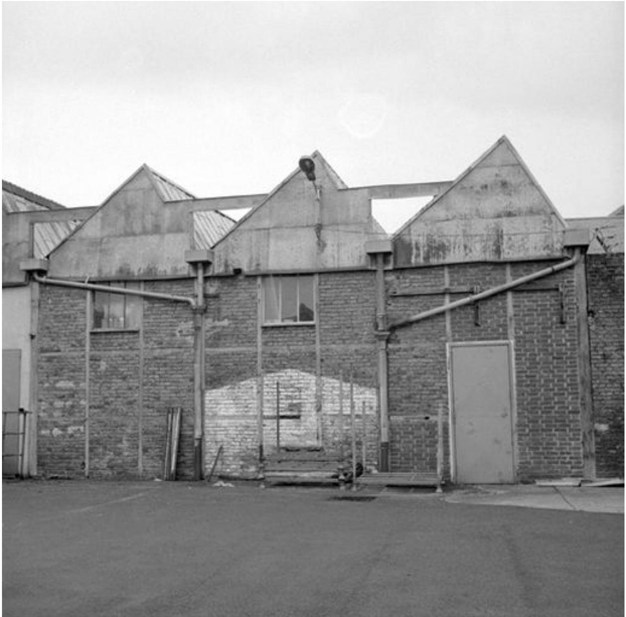
Atelier de fabrication, en 1990.
