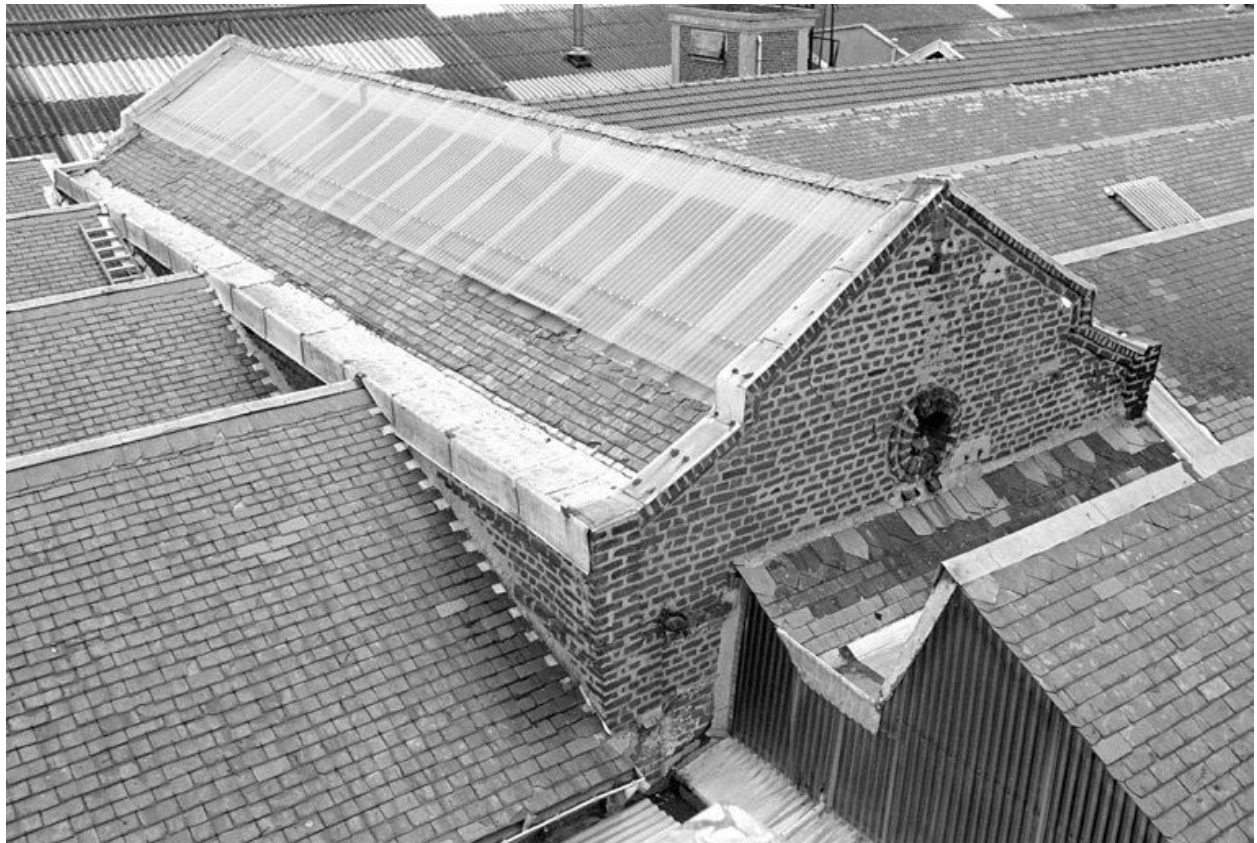
Atelier de fabrication, en 1990.
