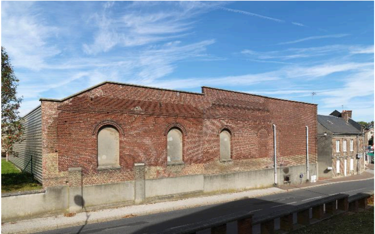
Vue générale des ateliers de fabrication.
