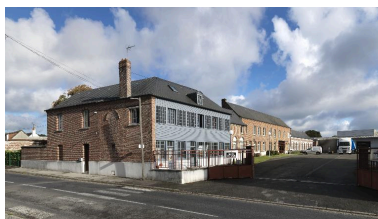
Vue de trois-quarts des bureaux.
