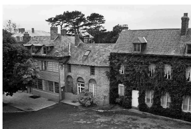
Conciergerie, bureau et vestiaires, flanc est, en 1990.
