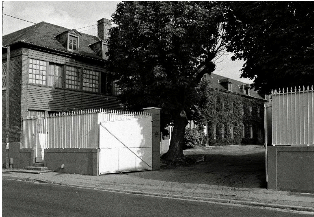
L'entrée du site, en 1990.
