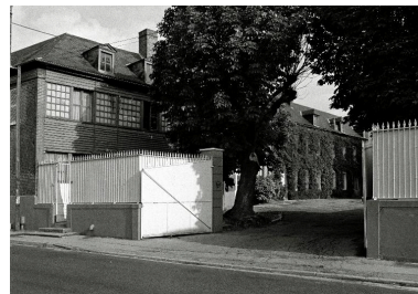
L'entrée du site, en 1990.
