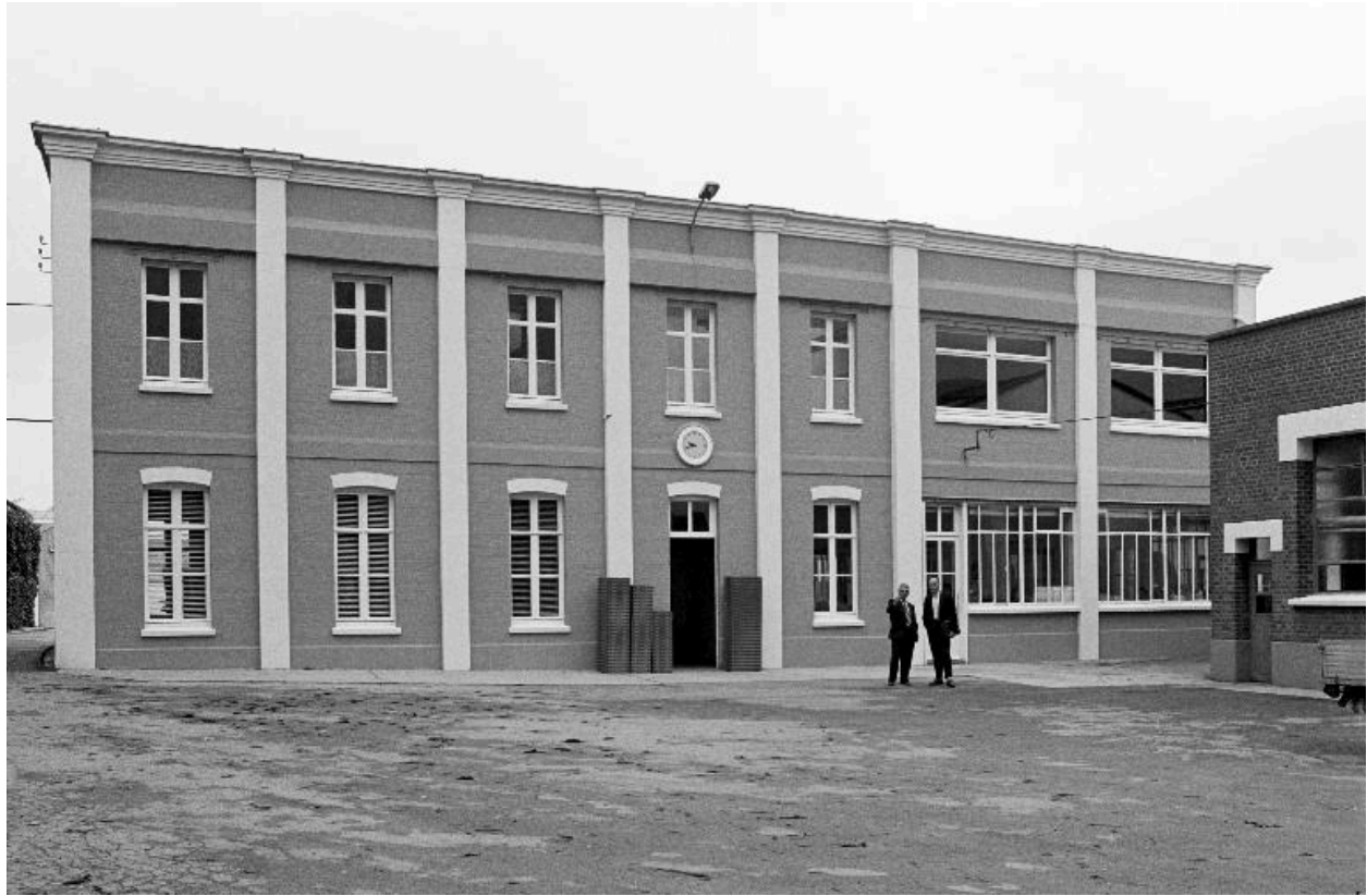
Bureau, flanc sud, en 1990.
