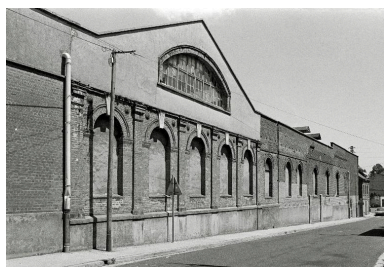
Les ateliers de fabrication depuis la rue du Chevalier de la Barre, en 1990.
