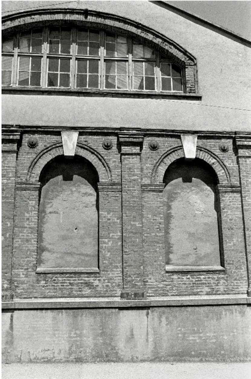
Détails de l'élévation sur rue des ateliers de fabrication, en 1990.
