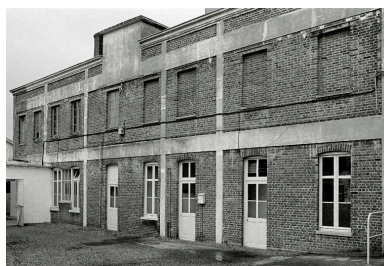
Elévation antérieure des bureaux, en 1990. Phot. Francis Dubuc IVR22_19908000523Z
