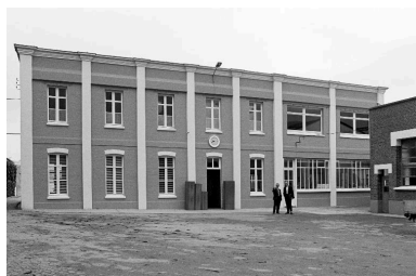
Bureau, flanc sud, en 1990.
