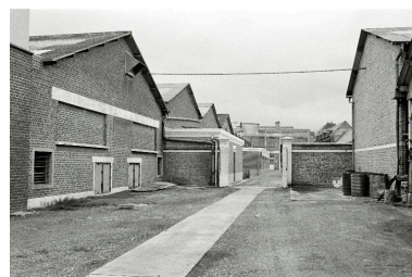
Vue partielle des ateliers de fabrication, en 1990. Phot. Francis Dubuc IVR22_19908000521Z
