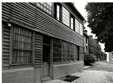
Détail de la conciergerie, en 1990. Phot. Francis Dubuc IVR22_19908000525Z
