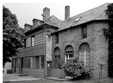
Elévation antérieure de la conciergerie, en 1990. Phot. Francis Dubuc IVR22_19908000524Z
