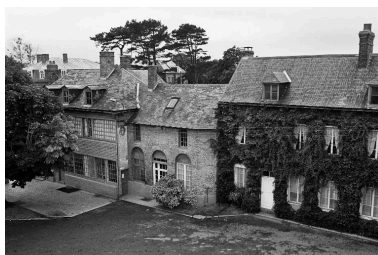
Conciergerie, bureau et vestiaires, flanc est, en 1990.
