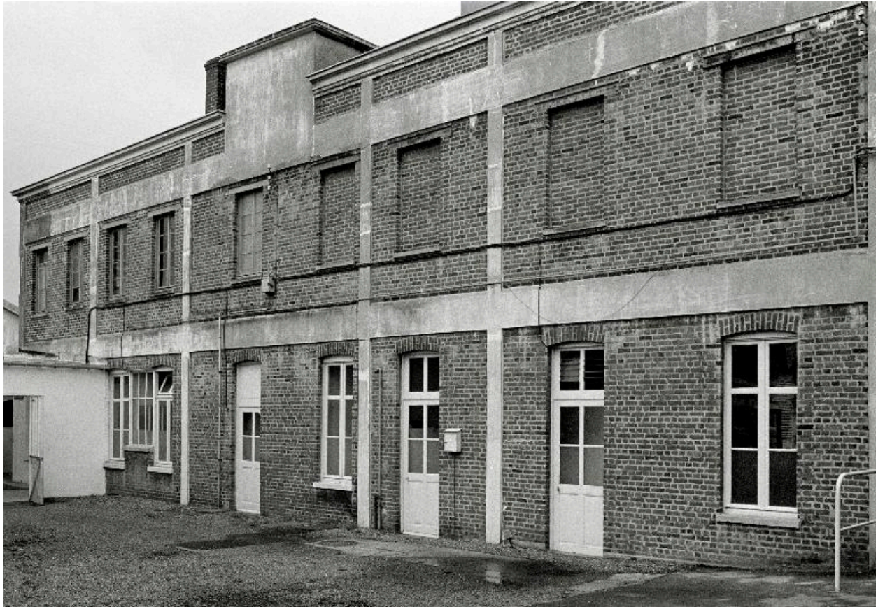
Elévation antérieure des bureaux, en 1990.
