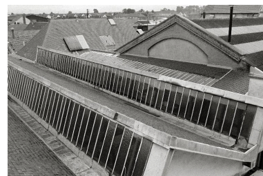
Détails des sheds de l'atelier de fabrication, en 1990. Phot. Francis Dubuc IVR22_19908000501Z
