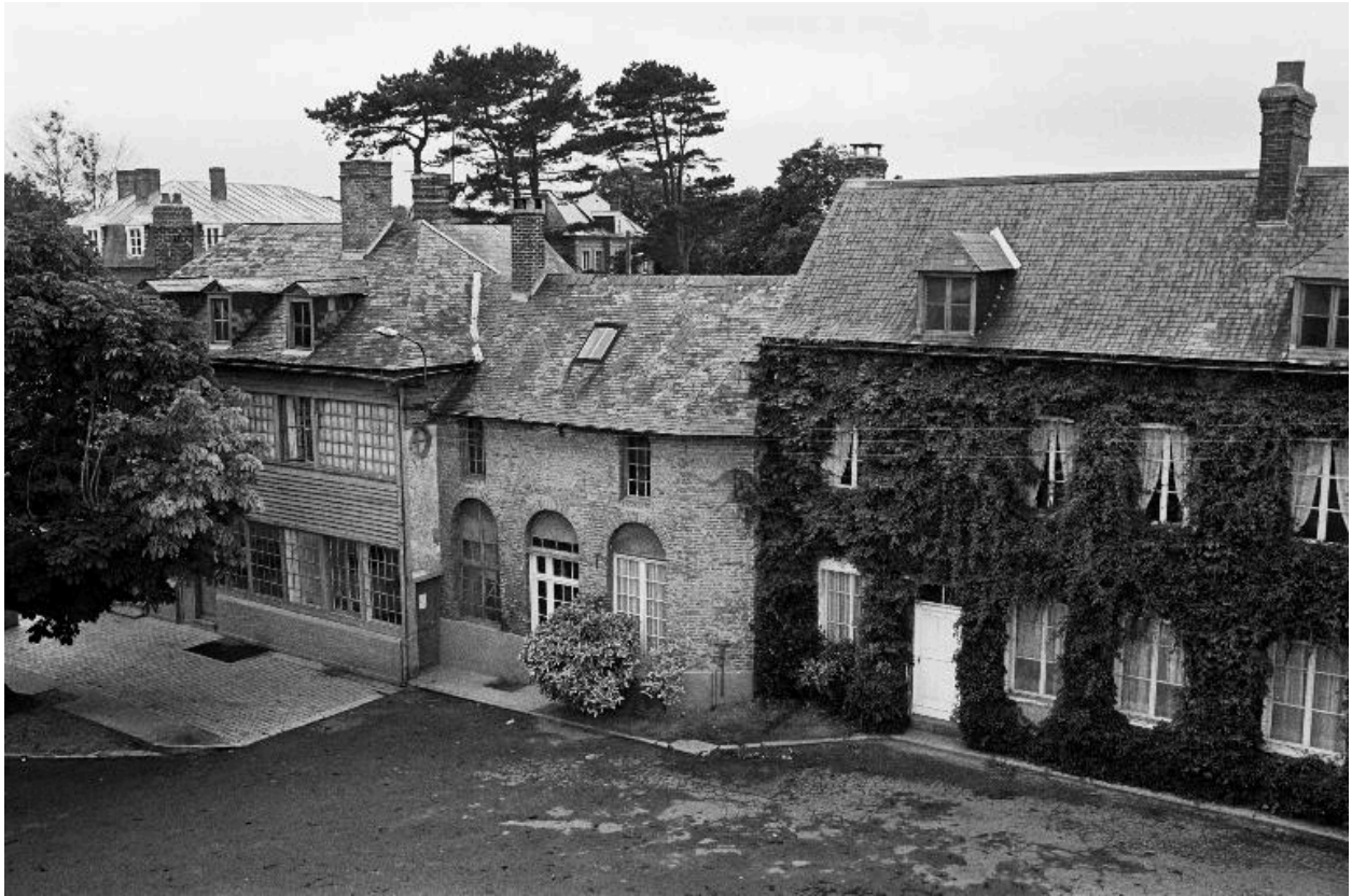
Conciergerie, bureau et vestiaires, flanc est, en 1990.
