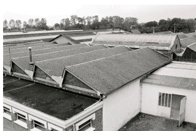
Détail de l'atelier des ateliers de fabrication, en 1990. Phot. Francis Dubuc IVR22_19908000500Z
