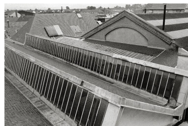
Détails des sheds de l'atelier de fabrication, en 1990.
