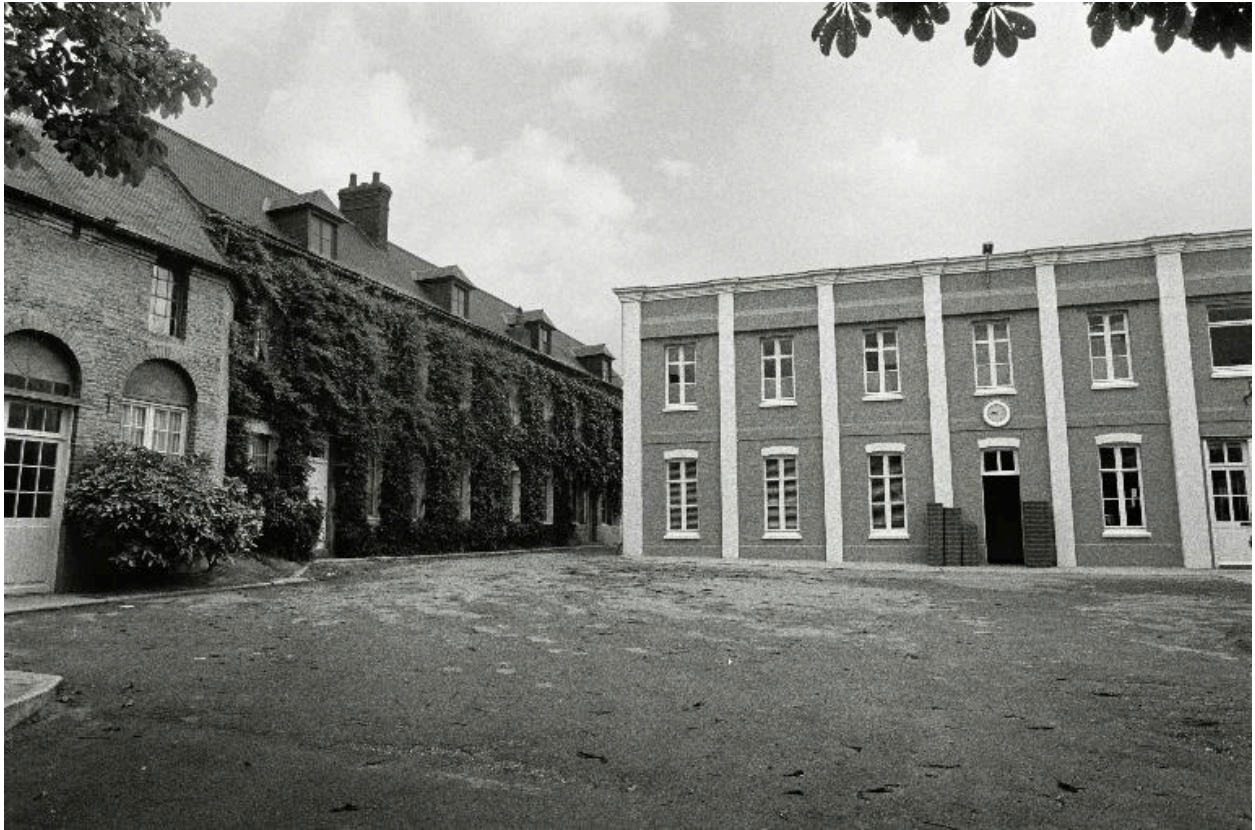
Elévation antérieure des bureaux, en 1990.
