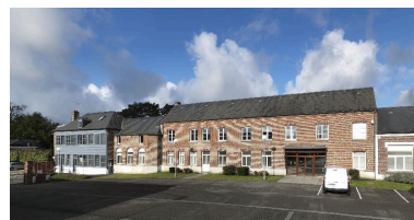
Vue de la façade antérieure des bureaux de l'entreprise.
