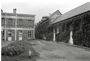
Vue partielle des ateliers de fabrication, en 1990. Phot. Francis Dubuc IVR22_19908000522Z
