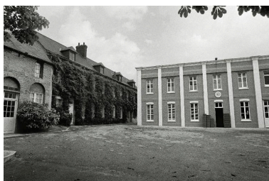
Elévation antérieure des bureaux, en 1990. Phot. Francis Dubuc IVR22_19908000527Z
