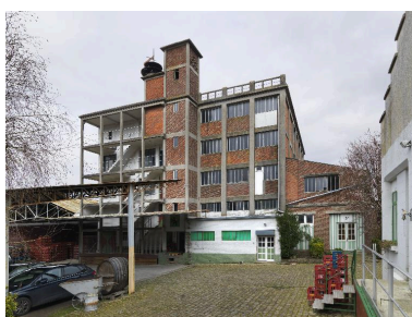
Vue d'ensemble sur cour de la brasserie.
