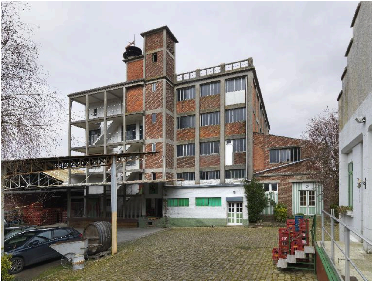
Vue d'ensemble sur cour de la brasserie.
