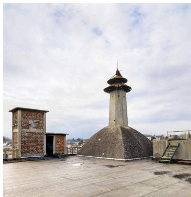
Cheminée de la malterie sur la terrasse de l'usine. Phot. Thierry Lefébure IVR32_20168000081NUC2A
