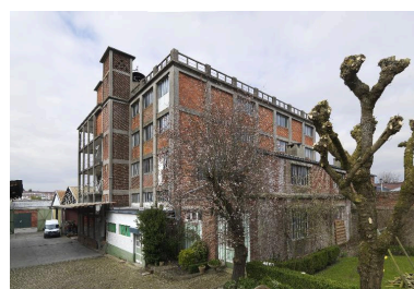
Vue d'ensemble de trois quarts de la brasserie.
