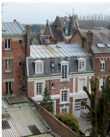
Façade postérieure du logement patronal de la brasserie, donnant sur la rue Saint-Sauveur. Phot. Bertrand Fournier IVR32_20168005182NUCA
