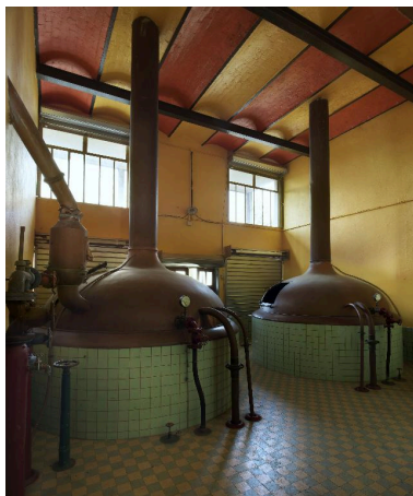
Salle de brassage. Phot. Thierry Lefébure IVR32_20168000086NUC2A
