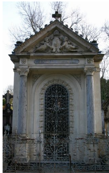
Vue rapprochée de la façade principale du tombeau-chapelle. Phot. Caroline Vincent IVR22_20088000276NUCA
