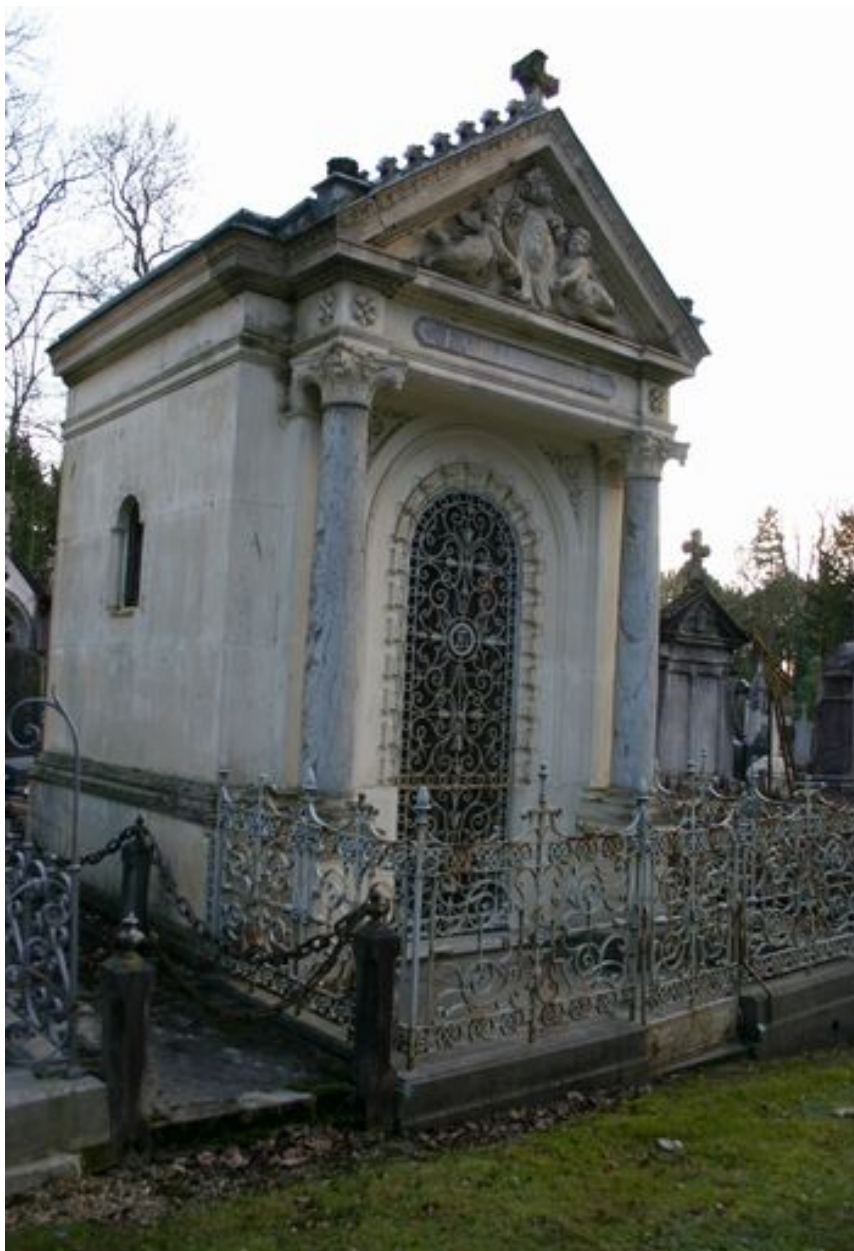
Vue générale, depuis le côté.
