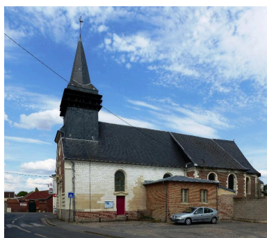
Vue de la façade sud. Phot. Isabelle Barbedor IVR32_20178005107NUCA
