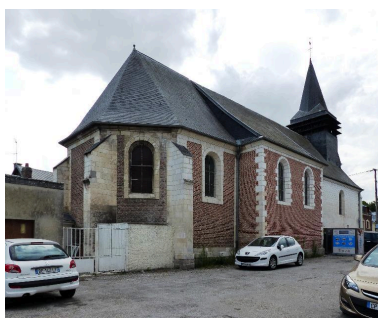
Vue depuis le nord-est. Phot. Isabelle Barbedor IVR32_20178005108NUCA
