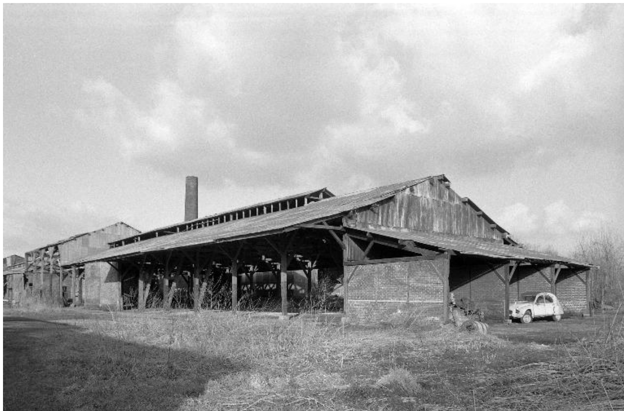
Hangar industriel, flanc sud.
