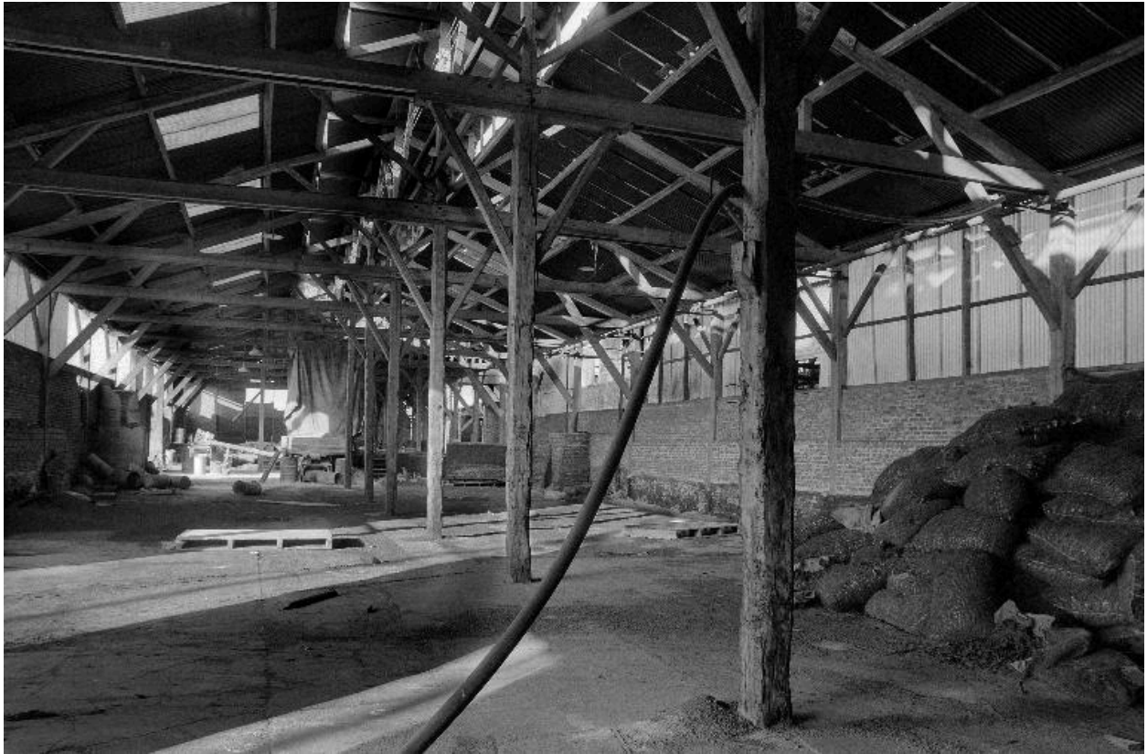
Magasin de stockage, vue intérieure.
