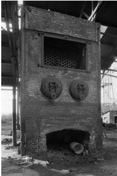
Chaudière à vapeur. Phot. Benoît Dufournier IVR22_19888000291Z
