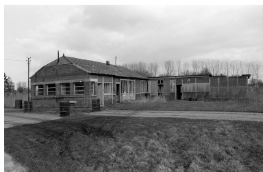
Bureau, pesage, toilettes, vestiaires. Phot. Benoît Dufournier IVR22_19888000257Z
