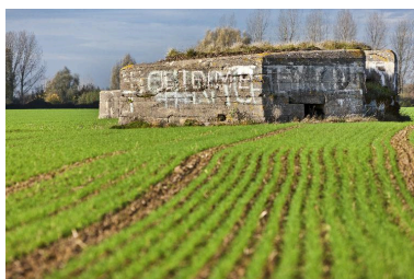
Vue générale, vers le nord. Phot. Jean-Marc Ramette IVR31_20145905144NUCA
