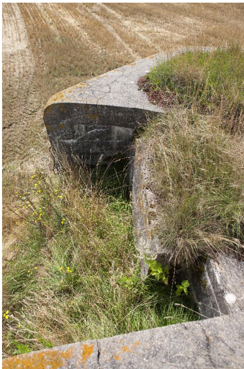
Banquette de tir depuis le couvrement, vers le sud-est
