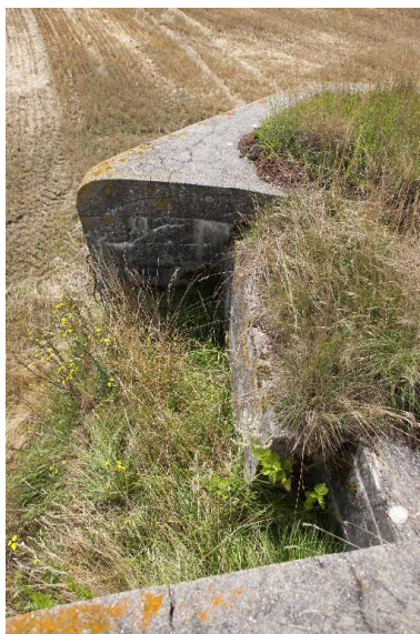
Banquette de tir depuis le couvrement, vers le sud-est Phot. Jean-Marc Ramette IVR31_20145905141NUCA
