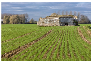
Vue générale, vers le nord. Phot. Jean-Marc Ramette IVR31_20145905145NUCA
