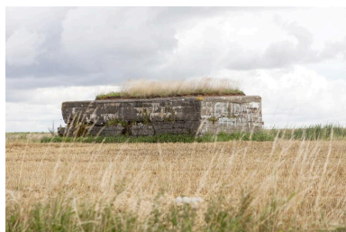
Elévation ouest Phot. Jean-Marc Ramette IVR31_20145905135NUCA
