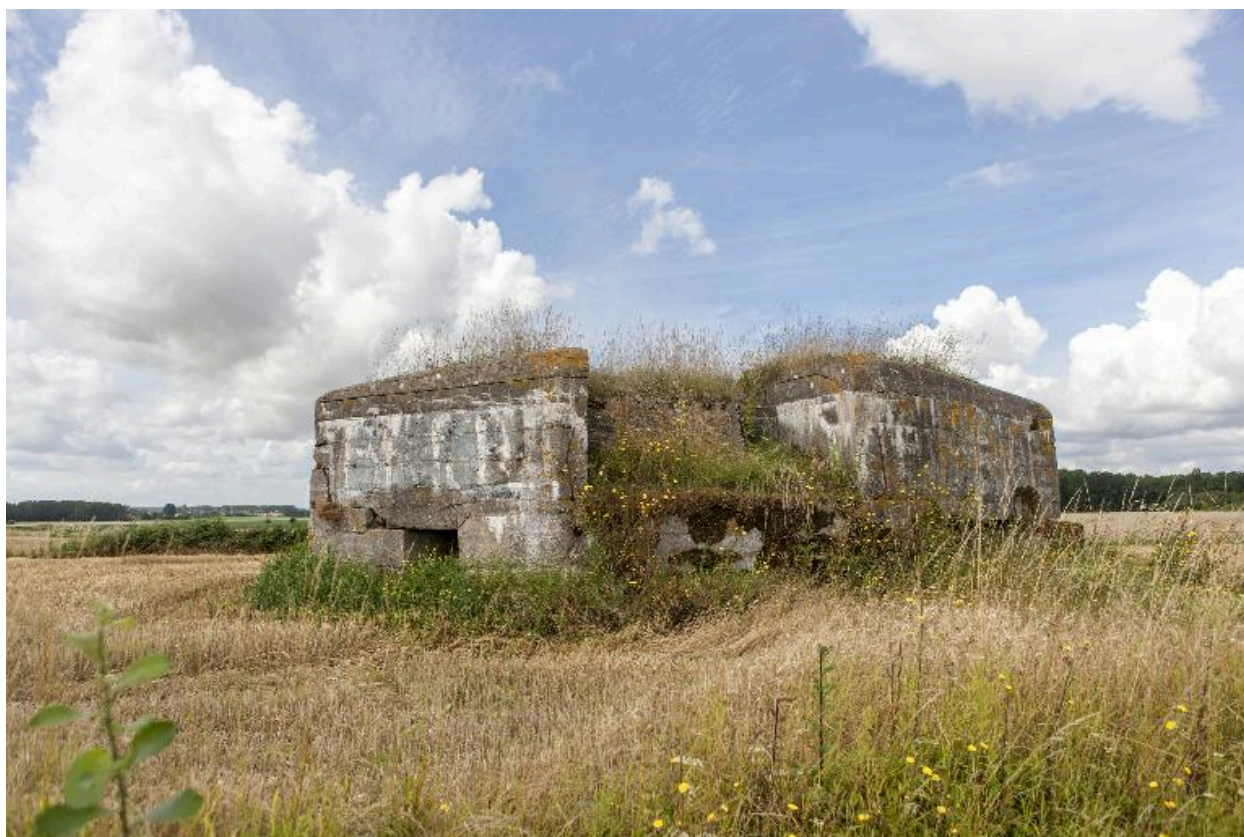
Vue frontale, vers l'ouest
