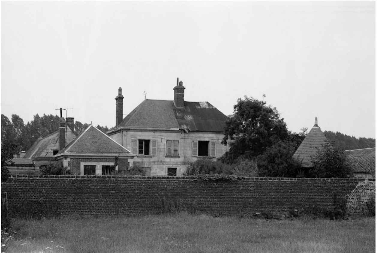
Vue générale postérieure.
