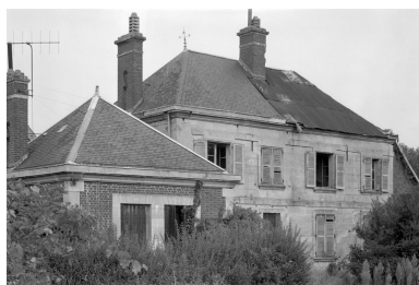
Elévation postérieure. Phot. Jean-Michel Perrin IVR22_19846001078X
