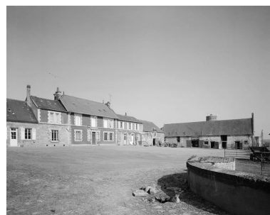
Logis et grange, depuis la cour. Phot. Jean-Michel Perrin IVR22_19856000580V
