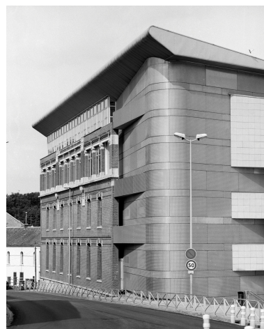
La façade des anciens bureaux de l'usine du Tilleul intégrée dans des bureaux du lycée André Lurçat. Phot. Thierry Petitberghien IVR31_20025901880X
